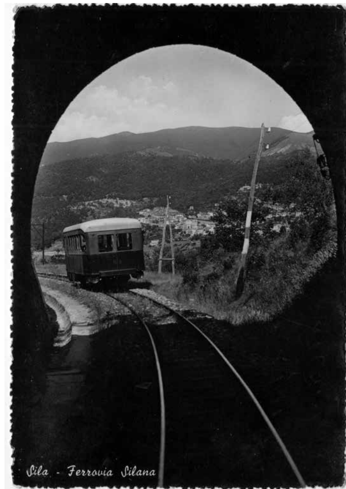
Una "Emmina" esce dal tunnel e si dirige verso una stazione a valle lungo la ferrovia silana. (Col. Salvo Bordonaro)
