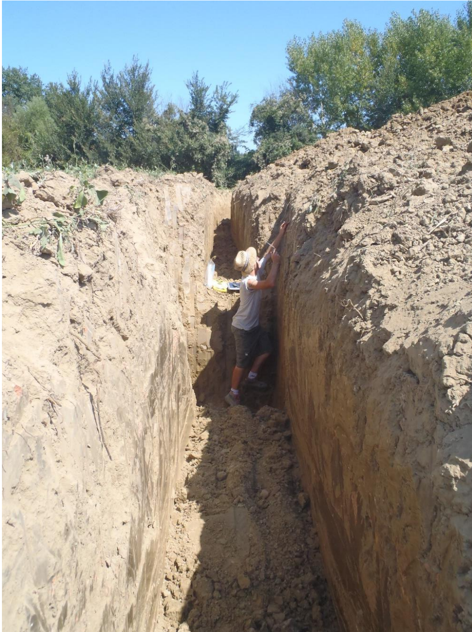
Fig.28. Trincee di scavo
