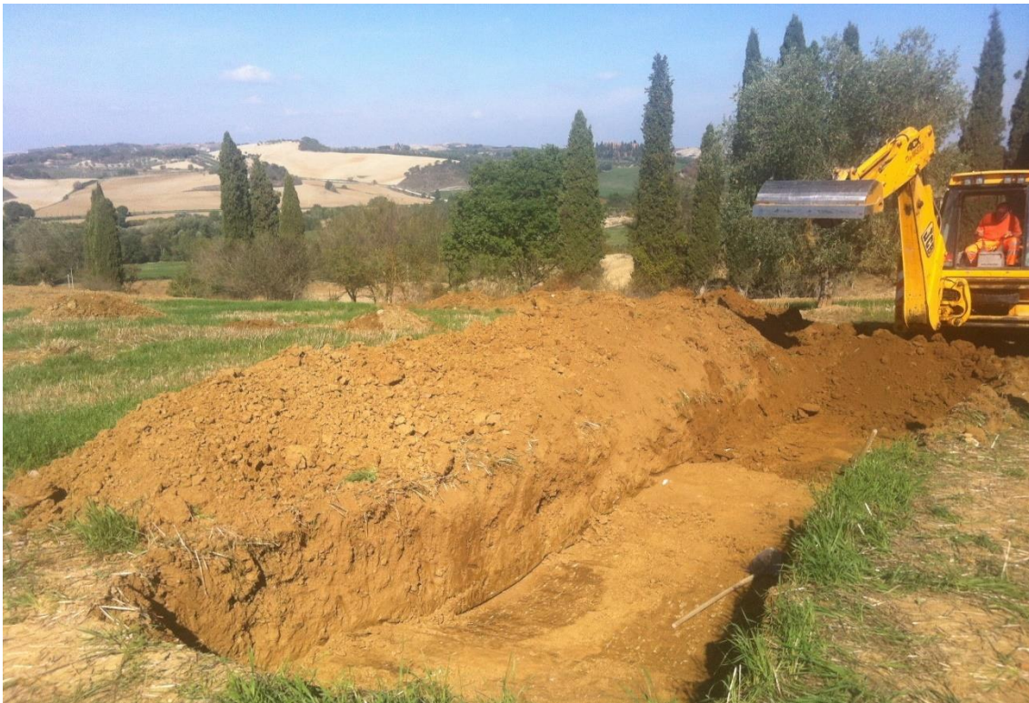
Fig.52. Apertura delle aree di scavo
