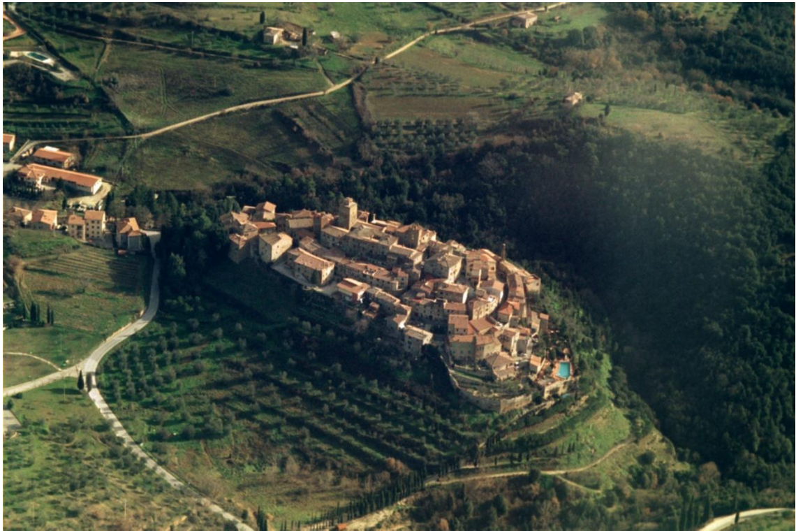
Fig. 15. 2004 - Fotografia aeree di Petroio
