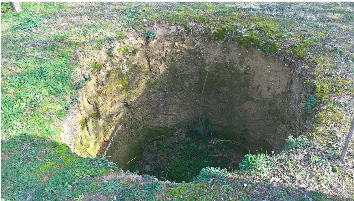
Fig.99. Cisterna sul pianoro del Podere San Lorenzo
