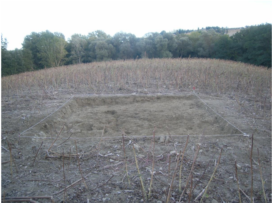
Fig.37. Area 6000 a seguito della rimozione dello strato superficiale
