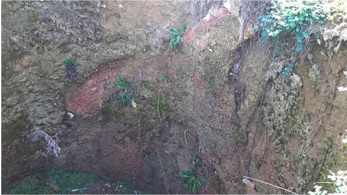
Fig.100. Cisterna sul pianoro del Podere San Lorenzo – dettaglio della parete con resti di rivestimento
