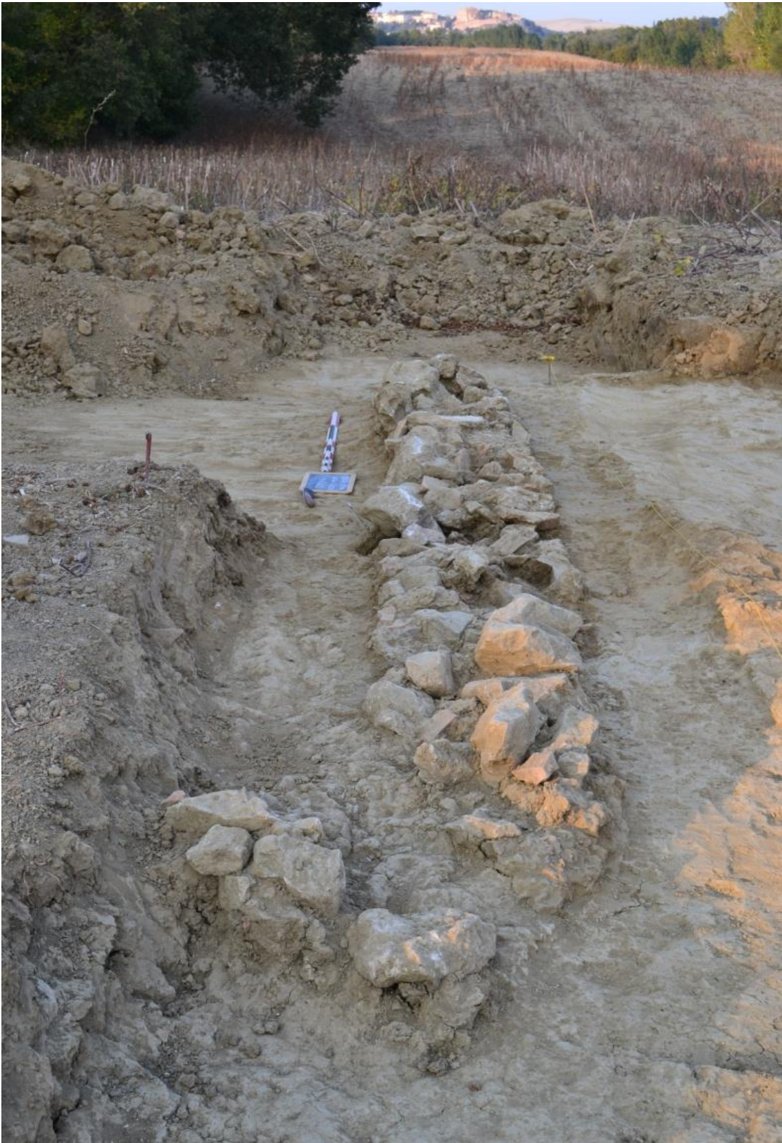
Fig.41. allineamento nord-sud della fondazione
