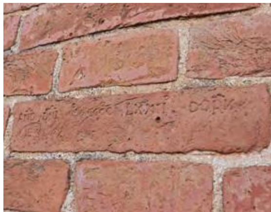
Iscrizione su un mattone della facciata recante la data "MCCCCLXXII"
