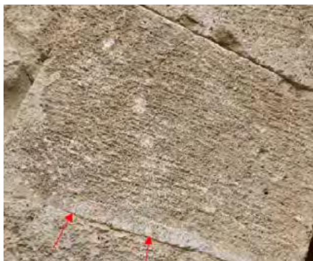
Fig. 11- Segni superficiali di strumento dentato. In evidenza le tracce del "nastrino"
