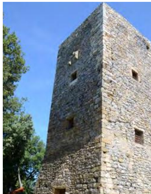
Montalceto, torre (CF 31.1). Prima e dopo il restauro
