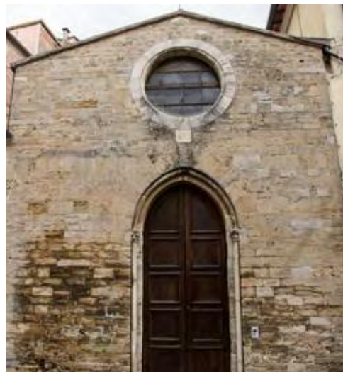
Facciata della chiesa, CF 9.1
