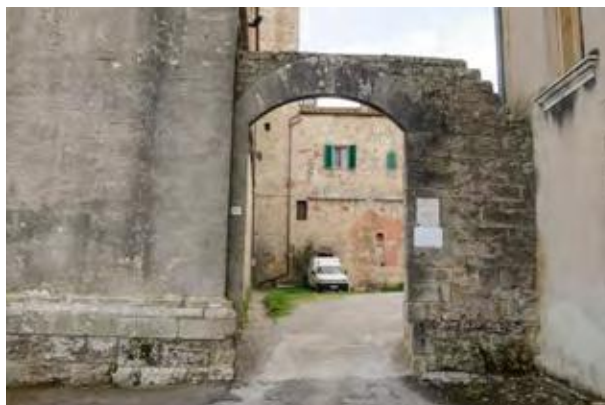
CF 7.5. Portale d'accesso (tipo PP15) al chiostro del convento
