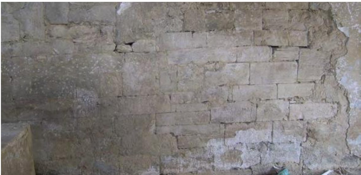
Fig. 35 - Tipo V. Paramento in pietra calcarea
