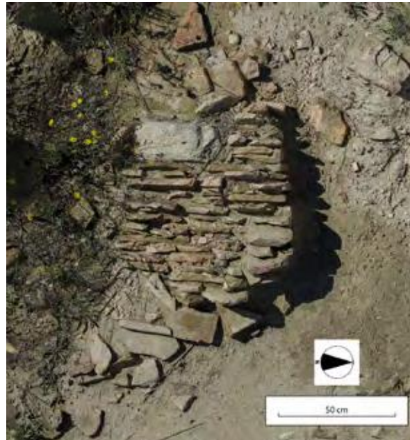
Fig. 24 - Paramento murario crollato (USM 95)
