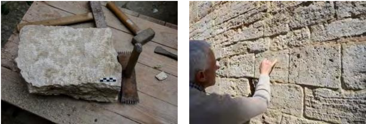
Fig. 12 - Esito di alcune dimostrazioni pratiche degli strumenti da lavoro e riconoscimento delle tracce sulle superfici
