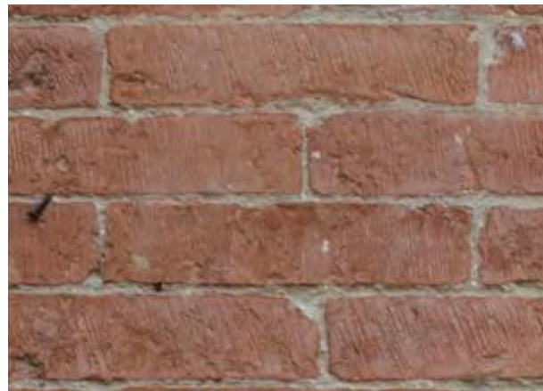
Fig. 9 - Segni di strumenti a lama piana su superfici in pietra (sinistra) e in mattoni (destra)
