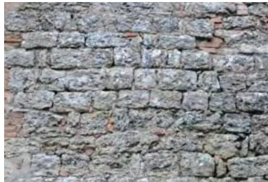
Molinello (CF 53.1), paramento murario
