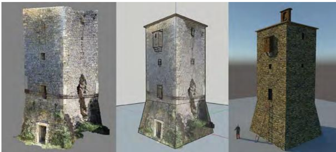
Fig. 189- Ricostruzione ipotetica della torre di avvistamento di Montalceto, realizzata in base al rilievo 3D effettuato
