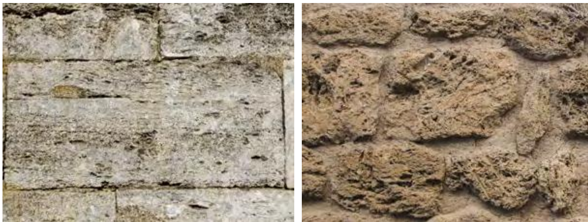
Fig. 2 - Conci di travertino rapolanese (a sinistra) e bozze di "gallazzone" (a destra)
