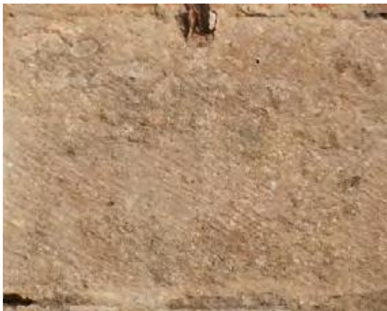
Fig. 9 - Segni di strumenti a lama piana su superfici in pietra (sinistra) e in mattoni (destra)
