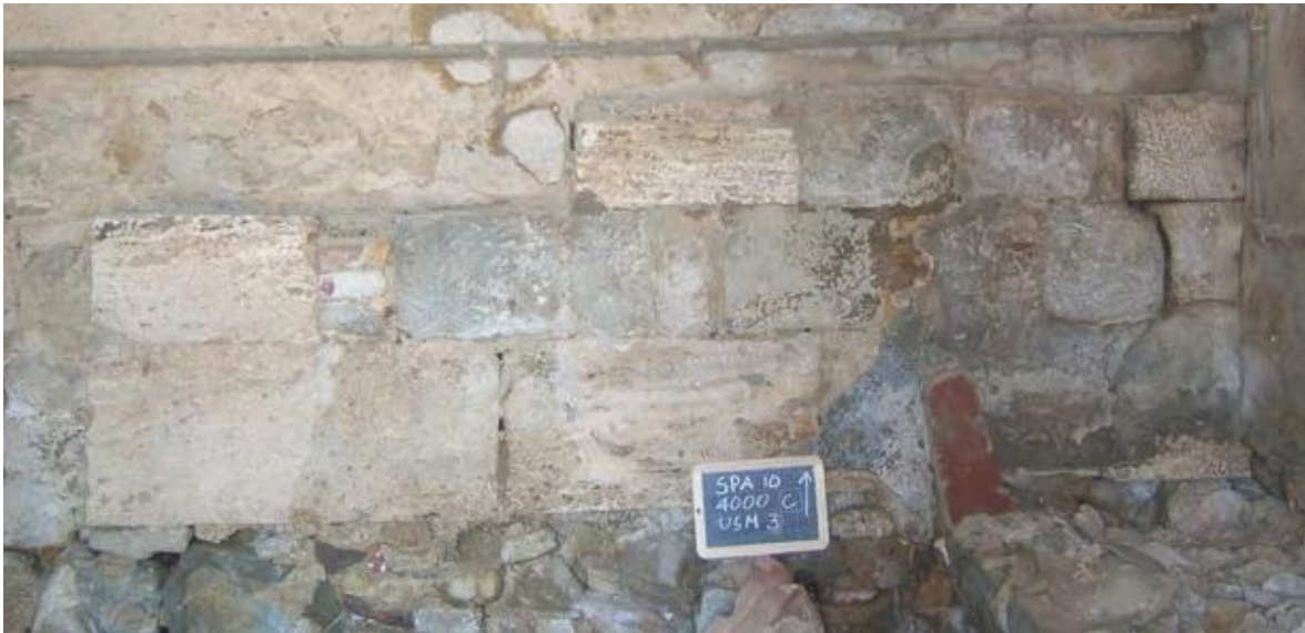
Fig. 34 - Tipo IV. Paramento bicromo
