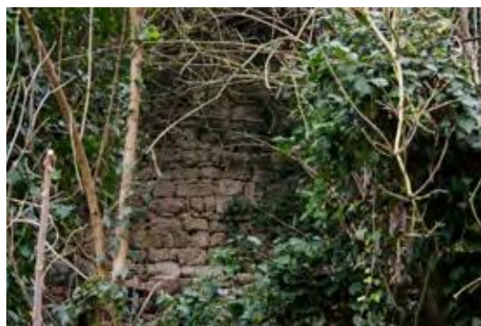
Tratto murario CF 1.19
