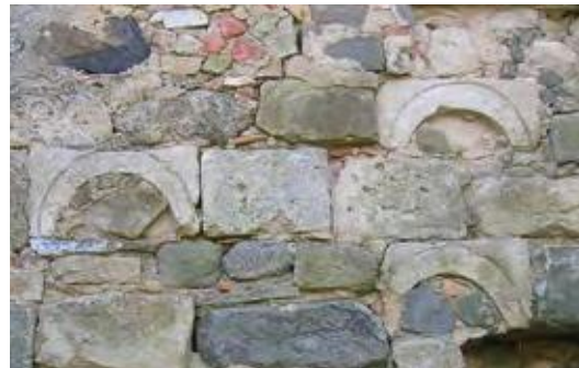
Fig. 38 - Archetti scolpiti visibili nei paramenti del podere attuale
