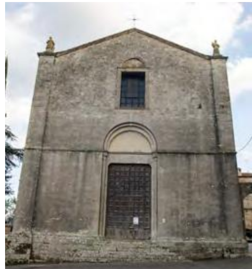
Facciata della chiesa, CF 7.1
