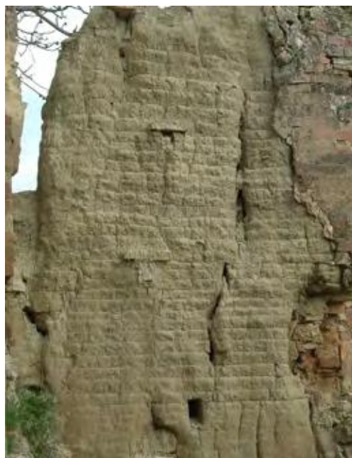
Imponente paramento in terra visibile tra i ruderi del Pod. Le Coste (CF 81.1)
