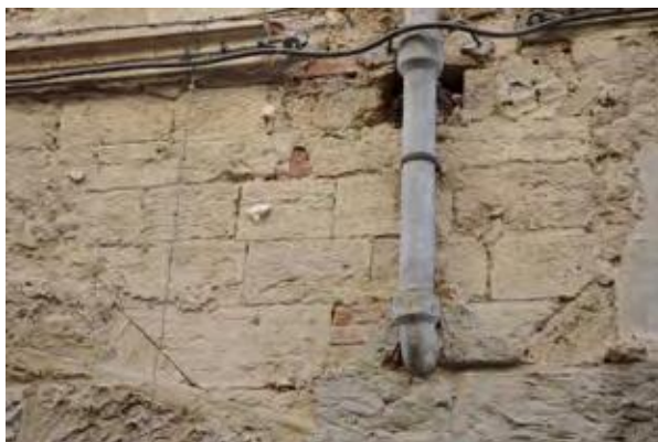
CF 16.2. Particolare del paramento a conci di travertino
