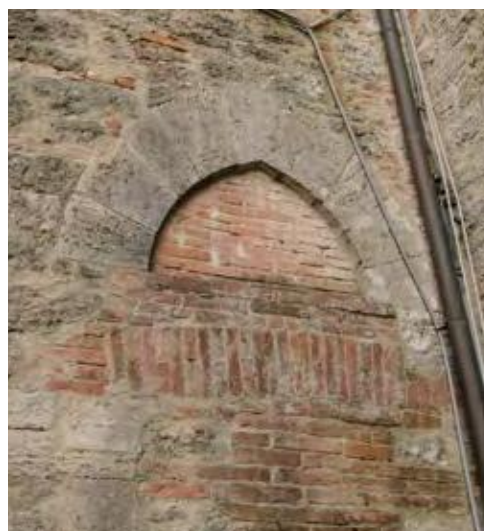
CF 7.1. Resti dell'accesso laterale (tipo PP8)
