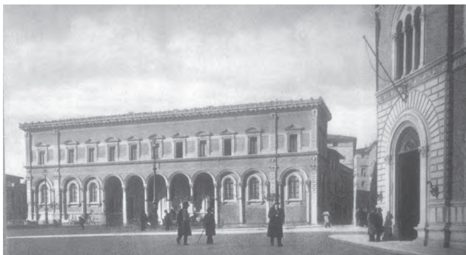
15) La piazza e sullo sfondo l'edificio camerale dopo gli interventi del 1927 e del 1929 con la chiusura delle campate laterali. Sulla destra si intravede il Palazzo Postelegrafonico.
