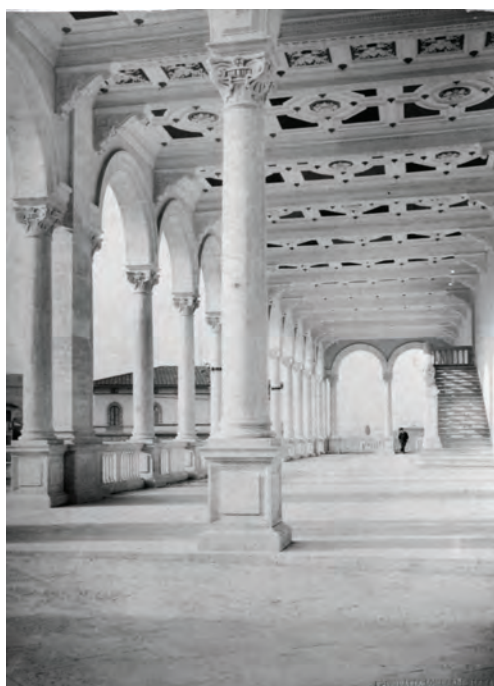
8) Il palazzo camerale entrato in funzione nel 1906: il prospetto verso la piazza (a) e il porticato con lo scalone (b: ACCSi, restauro di D. Renna, per gentile concessione). Le fotografie, scattate dal fotografo senese Lombardi, sono databili al 1905, subito dopo il completamento dell'edificio e prima della apposizione delle cerchiature in ferro delle colonne del portico.
