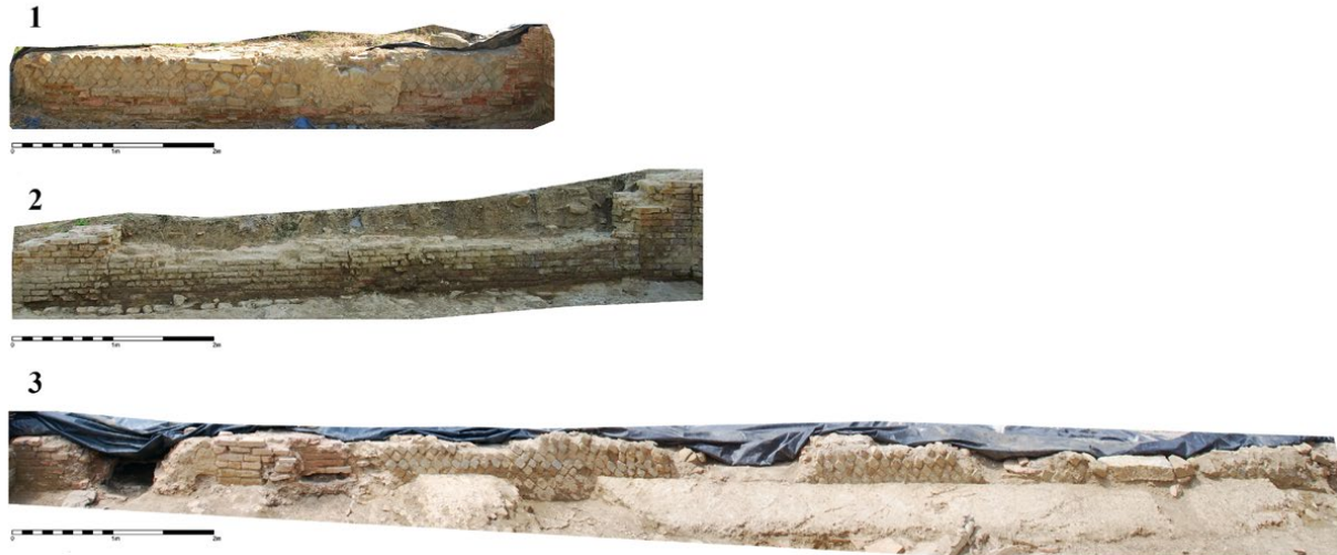
3 Santa Marta (Cinigiano, GR). Campionatura di tecniche costruttive murarie: 1. Paramento interno del lato nord dell'Ambiente 3, Edificio A ( opus mixtum e tamponatura tardoantica); 2. Paramento interno del lato nord dell'Ambiente 1, Edificio A (opera testacea); 3. Paramento esterno del perimetrale orientale dell'Edificio B ( opus mixtum con reticolato policromo), con la rampa in cocciopesto e le aperture aggiunte nella Fase III, tardo III-IV secolo d.C.
