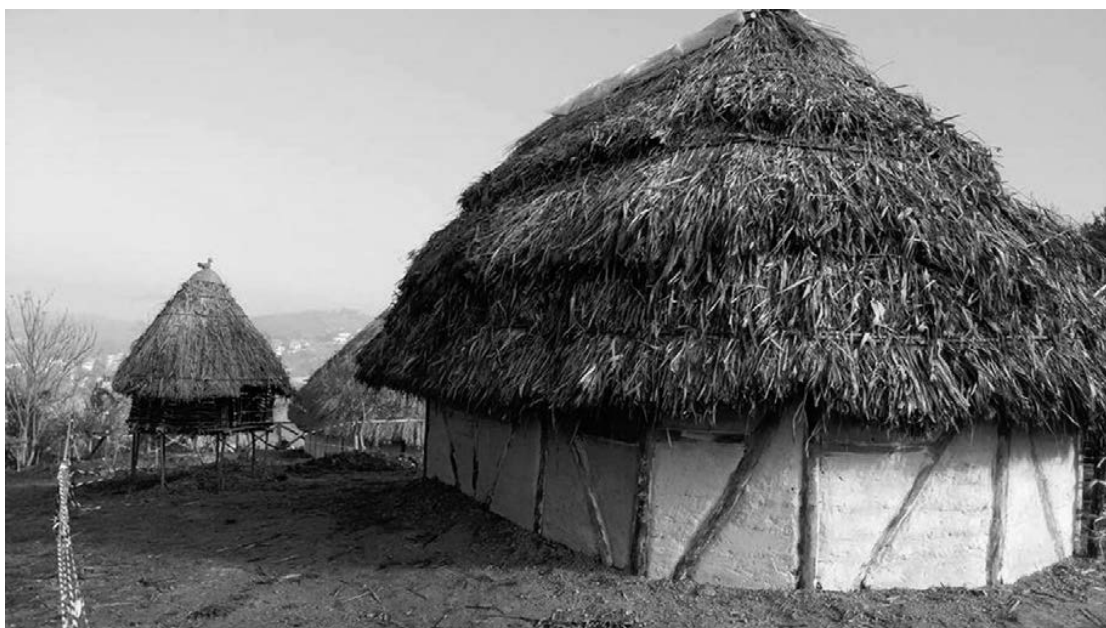
Figura 7 – Le nuove strutture in corso di conclusione.
