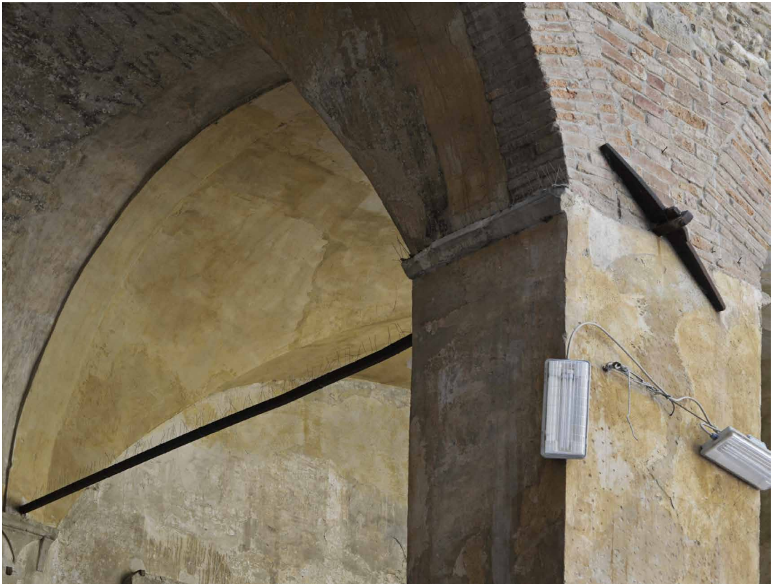
Figg. 5a | 5b | 5c Alcuni esempi di catene (in legno, in pietra ed in ferro) inserite nelle murature con funzione di "presidi antisismici" (le prime due immagini provengono dalla Pieve di San Lorenzo a Borgo San Lorenzo - FI; la terza fotografia ritrae un particolare di una catena inserita nelle murature interne di Palazzo dei Vicari di Scarperia - FI)
