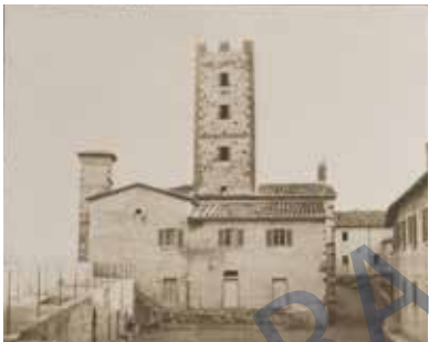
24 L'interno del borgo, a restauri ultimati nel 1902: si osservi la disposizione delle colonne romane provenienti dallo scavo della villa del Ginestraio (cortesia Archivio Corsini).
