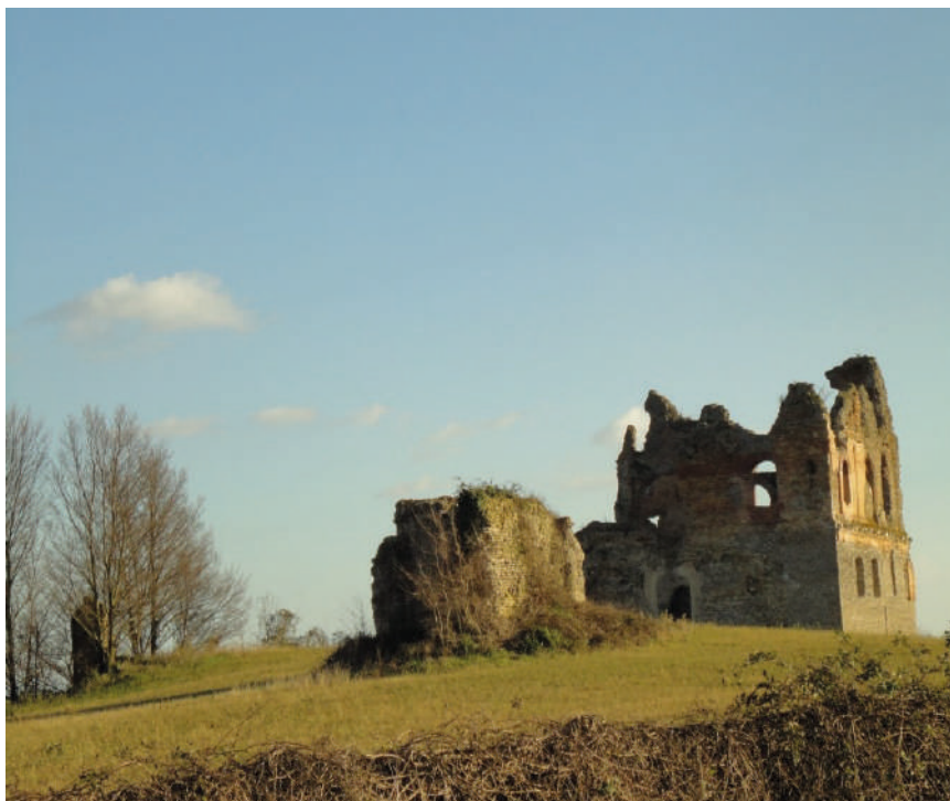
Foto 1. Mura di S. Stefano: vista d'insieme della cisterna (in primo piano), dell'abside (a sin.) e, in fondo, del 'torrione'
