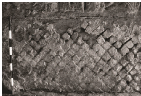
Fig. 15. Anguillara (vicolo della Grondarella): muratura in reticolato (cfr. fig. 12 G) dell'antica villa di Angularium (da G. CORDIANO, Sabatia Stagna , Pisa 2007, fig. 40)
