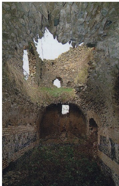
Foto 24. Casale di Spanora: l'interno dell'unica cisterna antica sopravvissuta vista da est verso ovest (da M. DOLCI et alii, Anguillara Sabazia e dintorni , Anguillara Sabazia 2008, fig. a p. 110)
