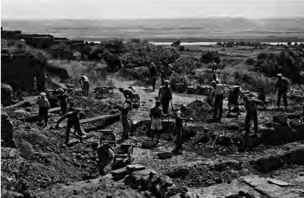
Fig. B23. Livello superiore, vista da nordovest: operazioni di scavo nella porzione orientale della piazza, del portico nord e della strada all'esterno del peribolo, 19 giugno 1962 (Jean Boube, © Aix Marseille Université, CNRS, Ministère de la Culture, Centre Camille Jullian, Aix-en-Provence, France – Archives).
