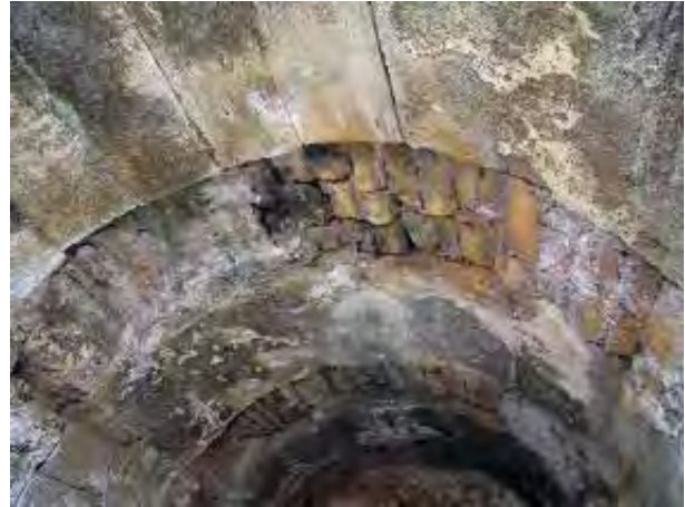
Fig. 4.30. Dettaglio della volta del castellum aquae al di sotto dell'Edificio con ninfeo.
