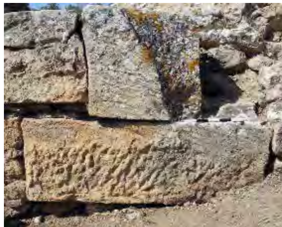
Fig. 4.45. Tracce di piccone da cavatore o piccozzina su un blocco dell'opera quadrata (prospetto est della nona taberna ); nella parte superiore e in vista della muratura la superficie del blocco è stata spianata con martellina a lama piana.
