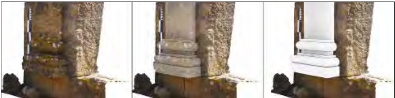
Fig. A1. Esempio di rilievo fotogrammetrico utilizzato per la ricostruzione di un elemento architettonico.
