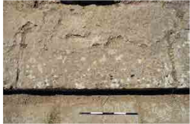
Fig. 2.50. Livello superiore, blocco del primo gradino della scalinata del tempio; si osservano i fori presso il limite est e la malta di allettamento del secondo gradino.
