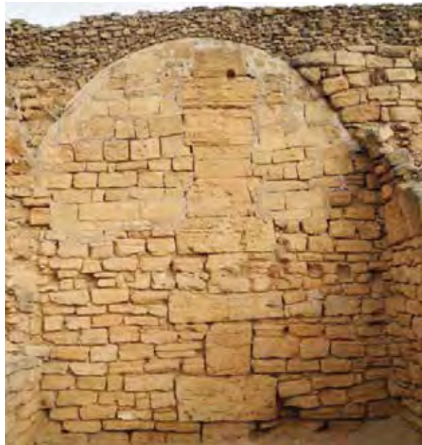
Fig. 2.19. Livello inferiore, seconda taberna , vista del muro di fondo.
