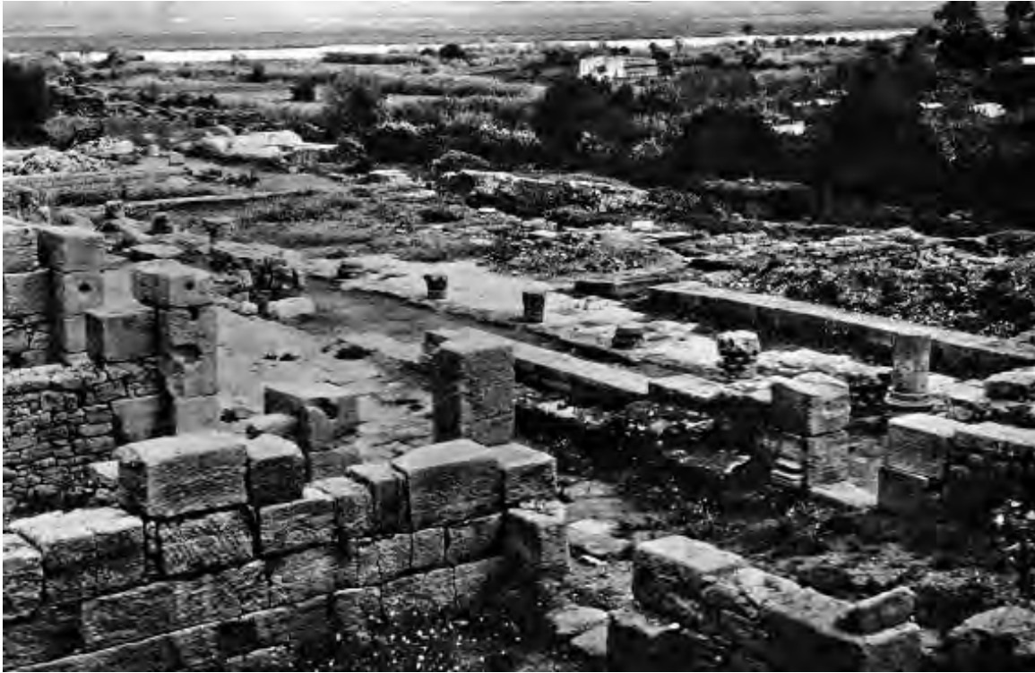
Fig. B70. Livello superiore, vista da nordovest: da destra verso sinistra si osservano il tempio, la piazza lastricata, lo stilobate del portico con capitelli e basi ricollocati per suggerire la posizione originaria delle colonne; in primo piano l'Edificio G, 24 dicembre 1965 (Henri Morestin, © Aix Marseille Université, CNRS, Ministère de la Culture, Centre Camille Jullian, Aix-en-Provence, France – Archives).
