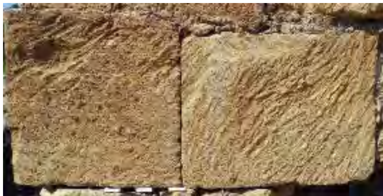
Fig. 4.47. Tracce di martellina a lama piana utilizzata per la spianatura della superficie di un blocco squadrato del prospetto est della nona taberna .
