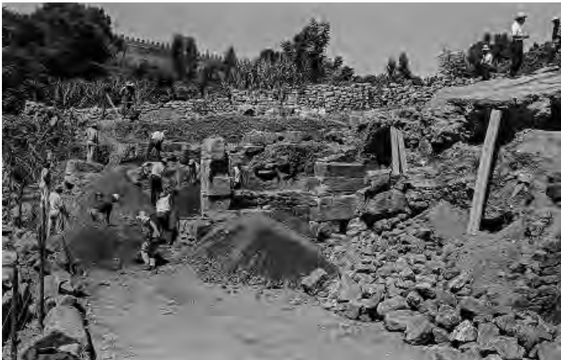
Fig. B43. Livello inferiore, vista da est: operazioni di scavo nelle tabernae e nella strada antistante, 13 luglio 1962 (Jean Boube, © Aix Marseille Université, CNRS, Ministère de la Culture, Centre Camille Jullian, Aix-en-Provence, France – Archives).
