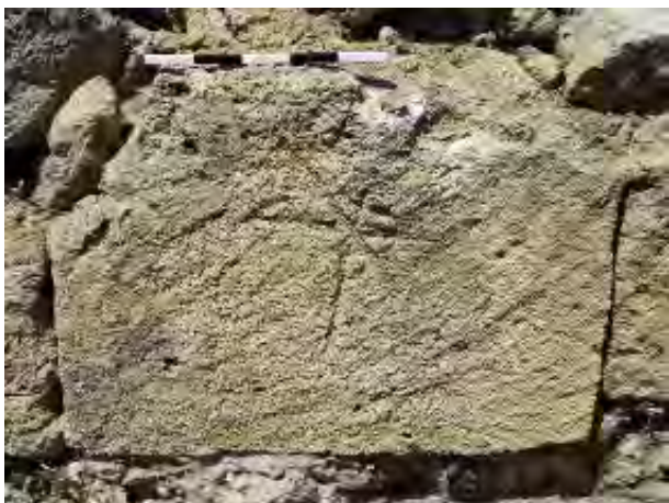
Fig. 4.36. Marchio di scalpellino a forma di asterisco.
