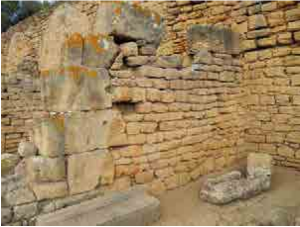
Fig. 2.22. Livello inferiore, muro divisorio fra le tabernae 4 e 5; si osservano il pilastro dell'armatura al centro del muro e i due blocchi conservati del filare di coronamento.
