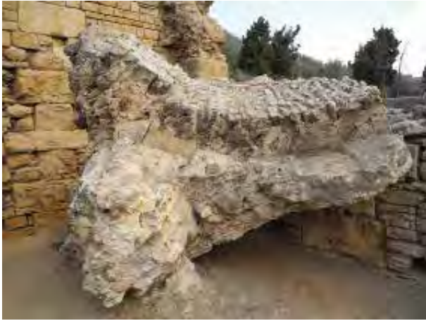
Fig. 4.25. Frammento di volte crollato nella taberna 9: sono visibili le tracce in negativo delle nervature.
