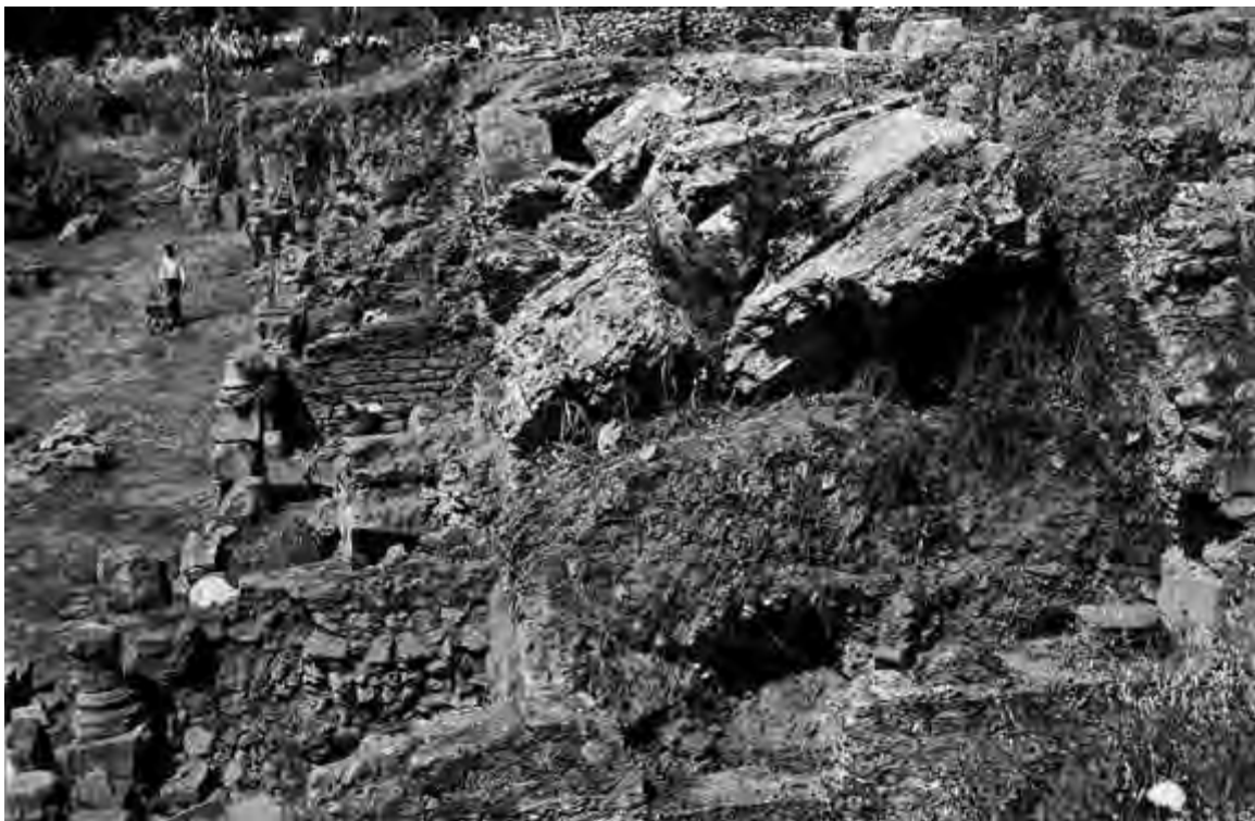
Fig. B24. Livello inferiore, vista da est: crollo delle volte delle tabernae , prima degli scavi effettuati da Boube, 19 giugno 1962 (Jean Boube, © Aix Marseille Université, CNRS, Ministère de la Culture, Centre Camille Jullian, Aix-en-Provence, France – Archives).
