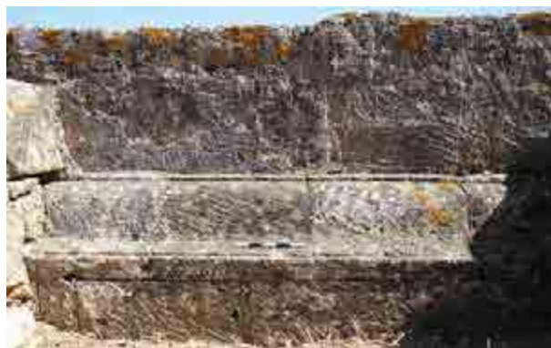
Fig. 2.53. Livello superiore, vista da nord della modanatura di base del podio del tempio.
