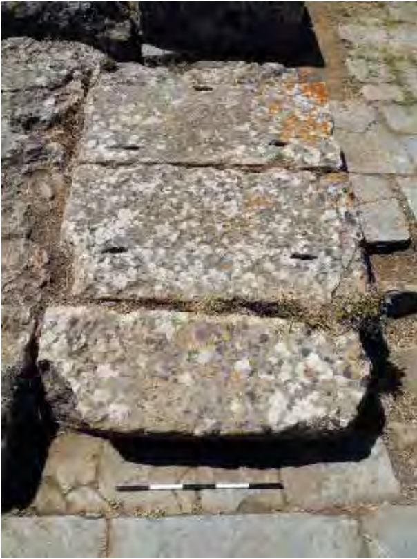
Fig. 4.38. Fori per leve sull'avancorpo della scala del tempio.
