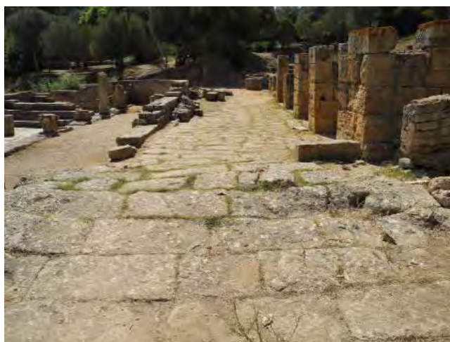
Fig. 2.34. Livello superiore, lastricato della strada nord visto da est, delimitato verso sinistra dal peribolo del Capitolium e verso destra dal fronte degli Edifici G1-G2.
