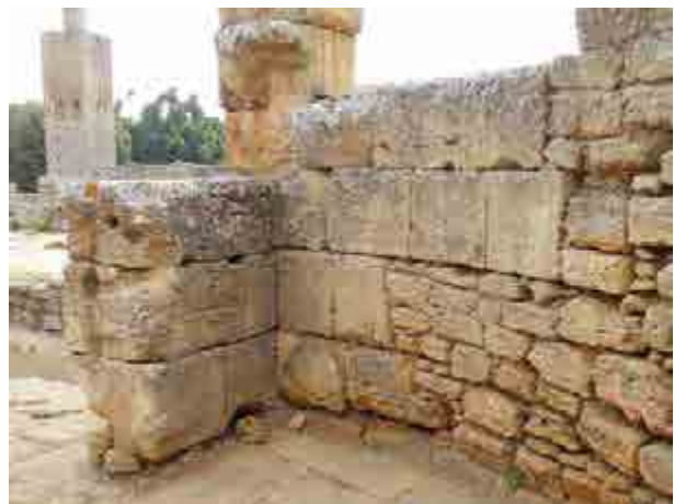
Fig. 2.13. Livello inferiore, vista dell'angolo interno sudovest della prima taberna ; si osservano lo stipite conservato della porta di passaggio tra prima e seconda taberna , il retro della lesena di facciata e l'inizio del muro perimetrale curvilineo, in opera quadrata nel primo tratto e in blocchetti verso ovest.
