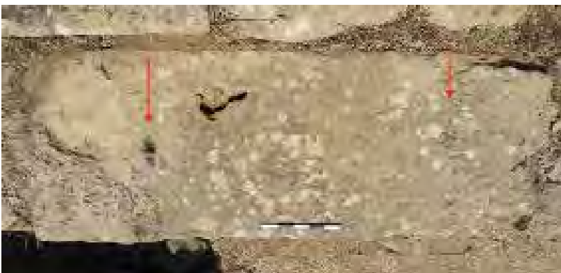
Fig. 4.44. Vista della superficie superiore del blocco alla figura precedente. I fori per leve, disposti lateralmente alla superficie spianata per l'appoggio del blocco superiore, sono indicati dalle frecce rosse.
