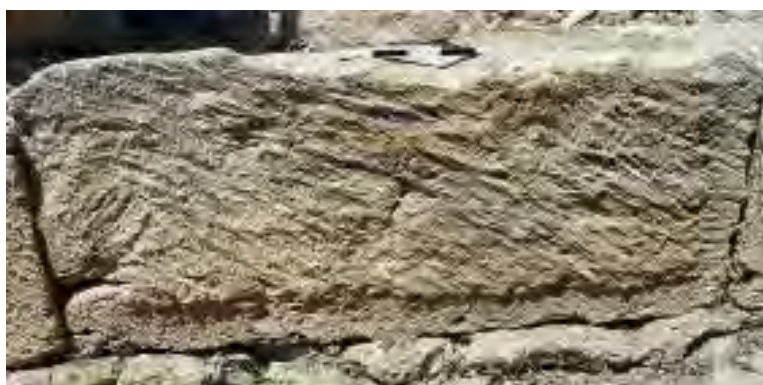
Fig. 4.46. Blocco del filare di imposta della facciata meridionale delle tabernae con nastrino lungo i bordi; il leggero bugnato è rozzamente spianato con la martellina a lama piana.
