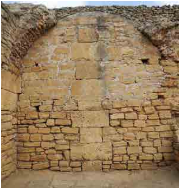
Fig. 2.18. Livello inferiore, prima taberna , vista del muro di fondo; si osservano la porzione inferiore originaria distinta da quella superiore di restauro, le porzioni originarie conservate delle reni della volta a botte e la ricostruzione della curvatura di intradosso della volta suggerita da un aggetto nella porzione di restauro della muratura.
