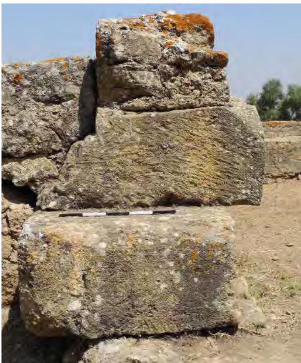
Fig. 2.52. Livello superiore, vista da ovest del muro del podio in sezione.
