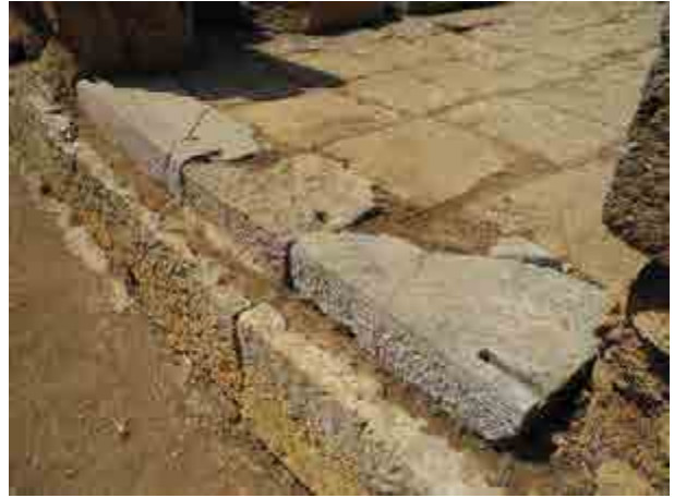
Fig. 2.24. Livello inferiore, quinta taberna , vista della soglia di ingresso in lastre di calcare rosa di restauro.
