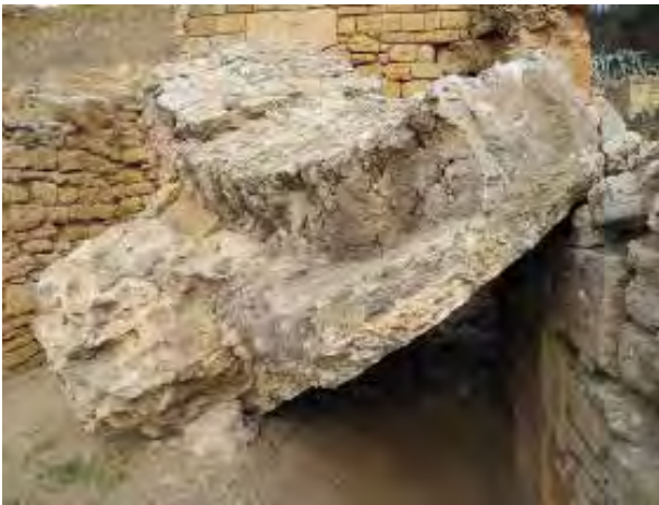
Fig. 4.26. Frammento di volte crollato nella taberna 9: sono visibili la traccia in negativo di una nervatura e lo strato di cocchiopesto che rivestiva l'estradosso piano della volta.
