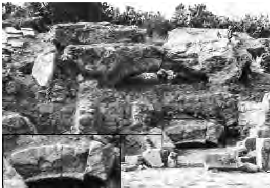
Fig. 4.31. Volte in crollo delle tabernae 7-8: dettaglio dei conci radiali di una nervatura; è visibile la lavorazione a intaglio della faccia laterale della nervatura per la creazione di un bordo aggettante lungo il profilo di intradosso.
