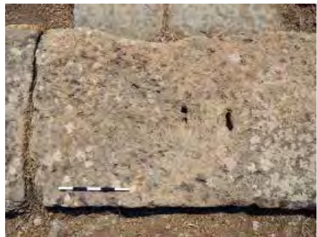
Fig. 4.13. Foro per leva intagliato sullo stilobate del portico nord; a sinistra del foro sono visibili le tracce di lavorazione con piccozzina.
