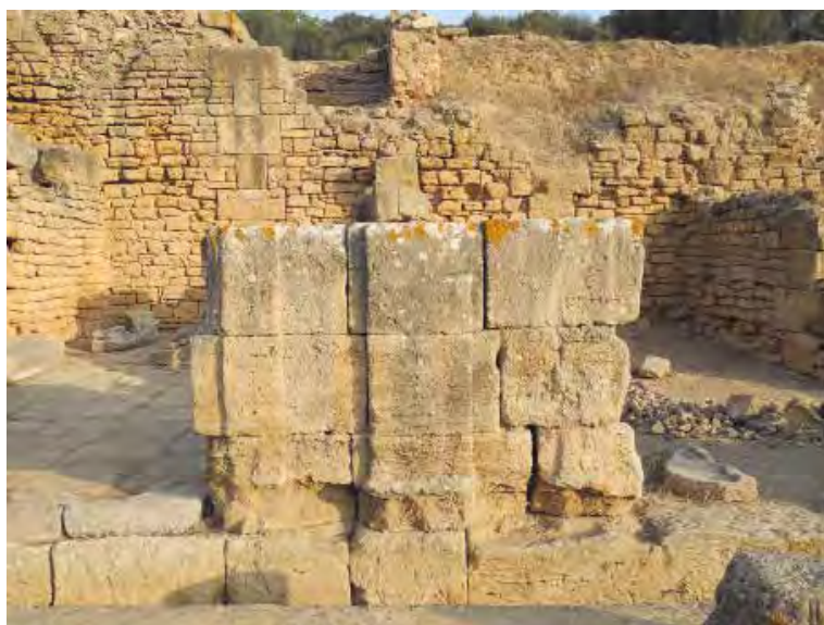
Fig. 2.7. Livello inferiore, vista da sud del muro di facciata delle tabernae in opera quadrata decorato da lesene: testata del muro divisorio fra le tabernae 5 e 6; al centro è visibile la lesena di dimensioni maggiori collocata in corrispondenza del muro divisorio interno, ai lati le lesene più piccole che inquadrano gli stipiti delle porte di ingresso.
