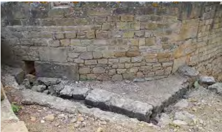
Fig. 2.32. Livello superiore, vista da ovest del canale di scolo delle acque provenienti dalla piazza del Capitolium .
