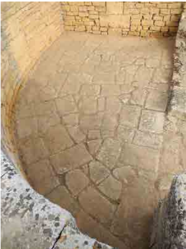
Fig. 2.12. Livello inferiore, pavimento di restauro della prima taberna .
