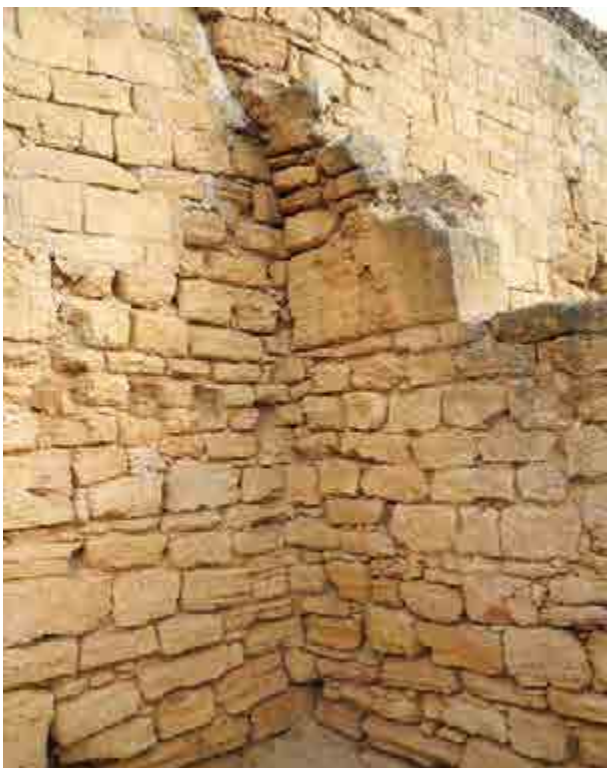
Fig. 2.20. Livello inferiore, seconda taberna , vista dell'angolo nord-est con il blocco di coronamento del muro divisorio e la parte conservata di una delle reni della volta a botte.
