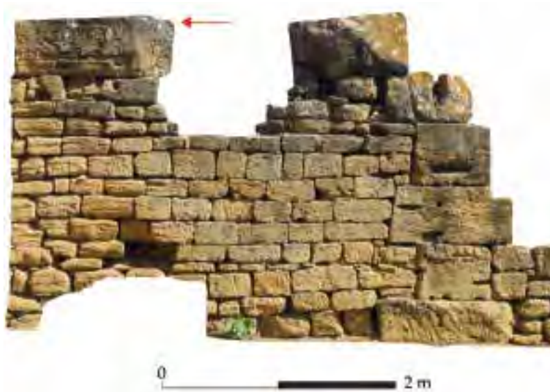
Fig. 4.23. Muro divisorio fra le tabernae 4 e 5, fotoraddrizzamento del paramento ovest. Sono visibili due blocchi del filare di coronamento e l'intaglio per il posizionamento di un arco in conci radiali, indicato dalla freccia.
