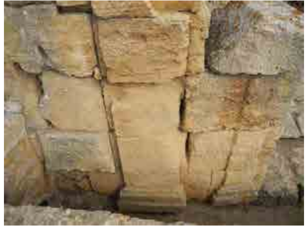
Fig. 2.16. Livello inferiore, facciata della prima taberna , dettaglio delle basi quadrangolari delle due lesene incassate nell'intercapedine creata dal muro di contenimento della strada antistante.
