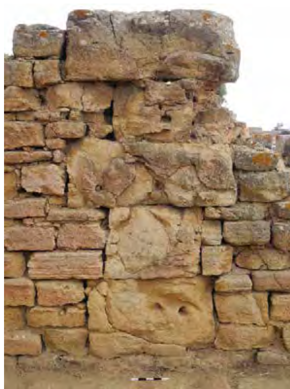
Fig. 2.21. Livello inferiore, terza taberna , vista del pilastro dell'armatura del muro ovest.
