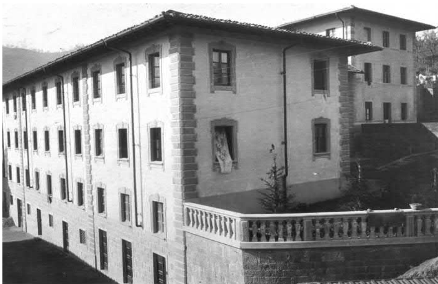
Figura 20. Il fabbricato detto Il Casone con gli alloggi riservati agli impiegati e tecnici del Lanificio e sede sociale storica della Società di Mutuo Soccorso per quasi 150 anni.
