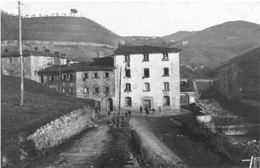
Figura 19. Conversione dei fabbricati de La Tintoria in case operaie per complessivi 93 vani (1909).
