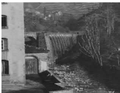
Figura 8. Il ponte canale edificato dal Siemoni (a destra).
