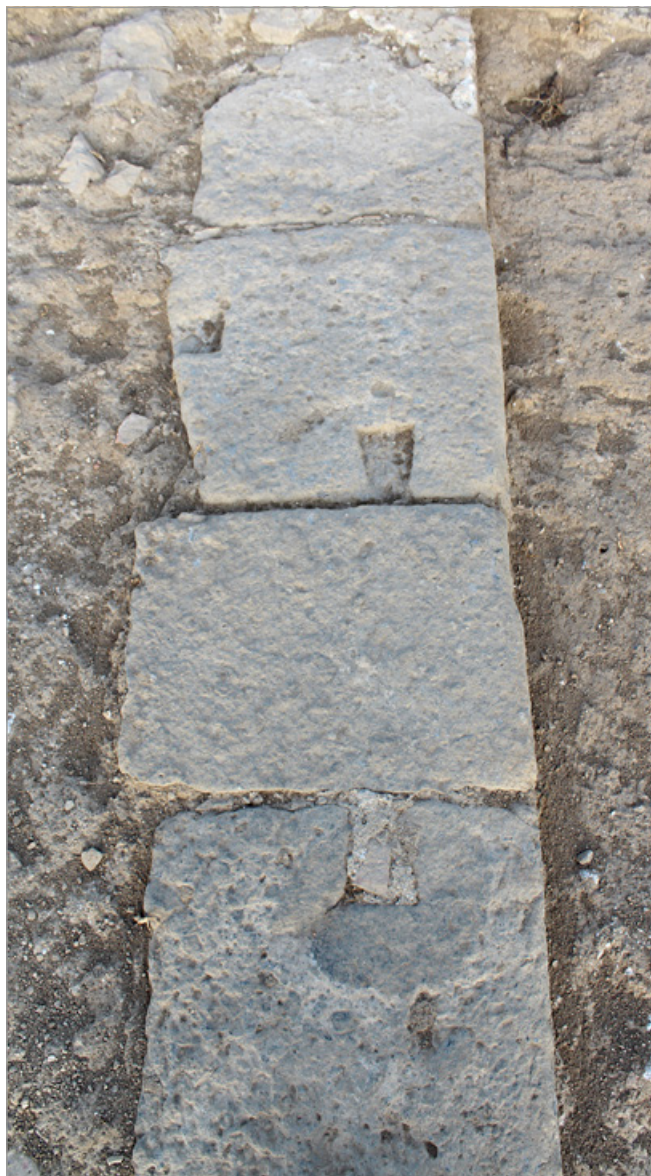
Fig. 5. Blocchi in pietra vulcanica di Romanou con alloggiamenti per grappe di età ellenistica reimpiegati negli stilobati della basilica proto-bizantina (el. C. De Domenico).
