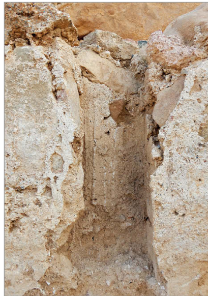
Fig. 9. Navata N. Alloggiamenti per pali di legno sulla banchina (USM 608) lungo il lato N (foto D. Firindelli; © Archivio fotografico SAIA U/13341).
