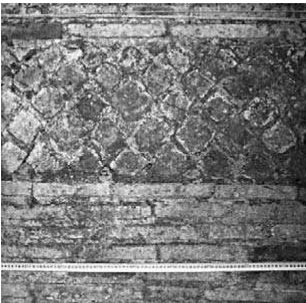
7. Via G. Baccelli. Ambiente 2: parete E. Dettaglio della tecnica edilizia (foto M. Modolo).
