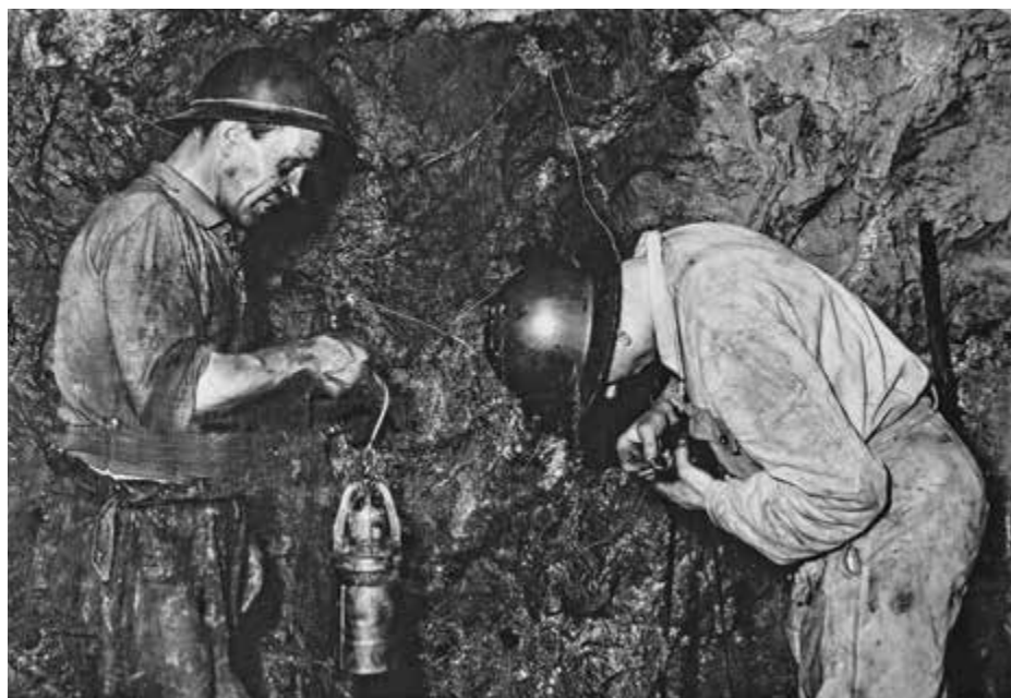
Corrado Banchi Caricamento della "volata", miniera di Niccioleta, 1956 Grosseto, Archivio Corrado Banchi
