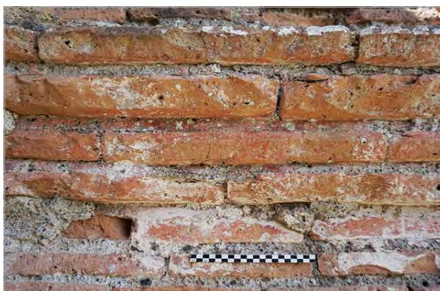
fig. 16 – Ostia, vista frontale di una cornice di appoggio di un solaio nelle Terme di Nettuno (II.iv.2): sopra al metrino è visibile l’ultimo filare del paramento sottostante la cornice, anch’esso dipinto di rosso; al di sopra si trovano i quattro filari sporgenti di “piccole tegole”; il quinto filare dal basso, originariamente di bipedali, è fratturato. Archivio Fotografico del Parco Archeologico di Ostia Antica.
