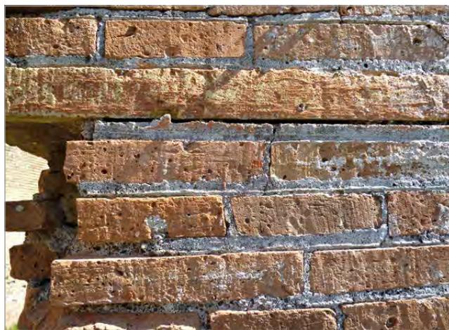
fig. 18 – Ostia, dettaglio di uno dei filari in bipedali dipinti in ocra rossa in un pilastro del cardine massimo (cd. Portici di Pio IX); sono visibili anche le tracce della finitura dei giunti effettuata passando uno strumento a punta (forse l’estremità della cazzuola) sul bordo superiore dei laterizi. Archivio Fotografico del Parco Archeologico di Ostia Antica.
