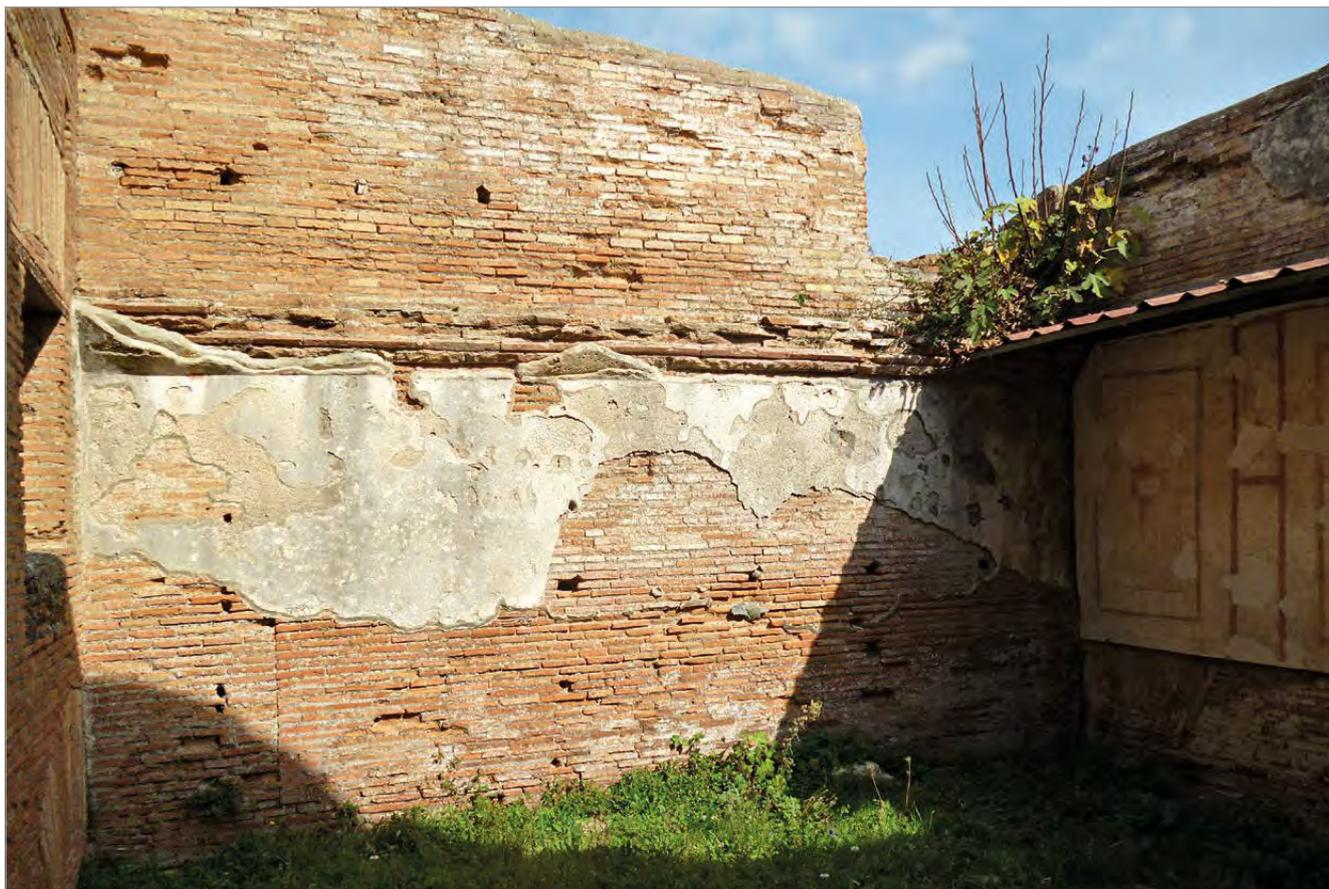
fig. 10 – Ostia, cornice di appoggio di un solaio nel Caseggiato delle trifore (III.iii.1). Archivio Fotografico del Parco Archeologico di Ostia Antica.
