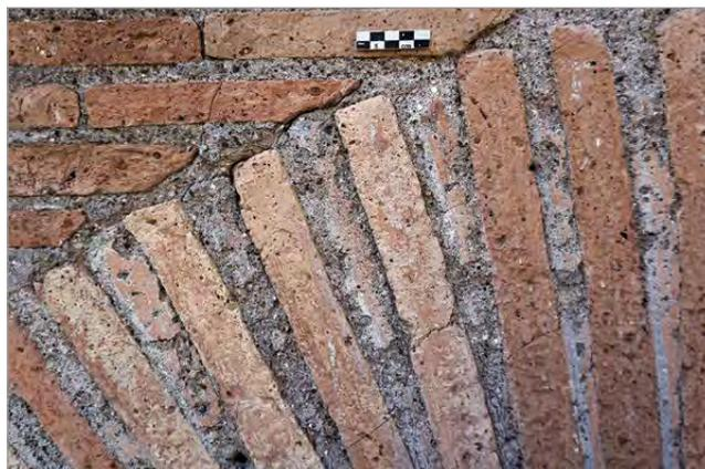
fig. 15 – Ostia, dettaglio della pittura in ocra rossa sui bipedali dell’arco di scarico nel Caseggiato delle trifore (III.iii.1). Archivio Fotografico del Parco Archeologico di Ostia Antica.
