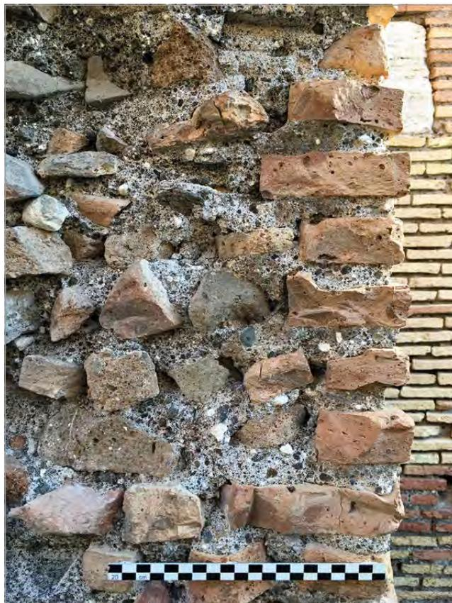
fig. 6 – Ostia, sezione di una muratura con paramento in “piccole tegole” nella Caserma dei Vigili (II.v.1-2). Archivio Fotografico del Parco Archeologico di Ostia Antica.
