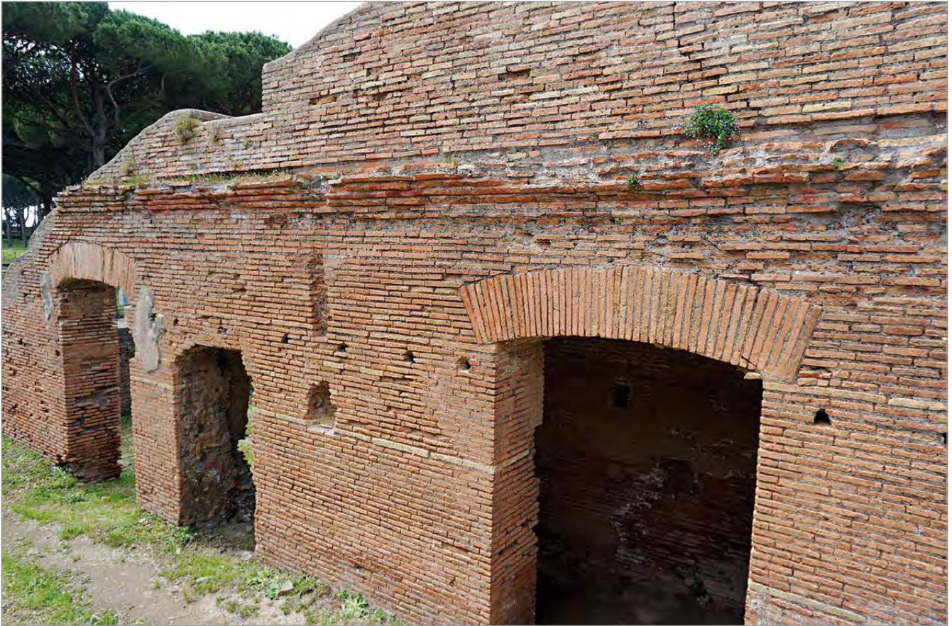
fig. 9 – Ostia, cornice di appoggio di un solaio nel Caseggiato delle fornaci (II.vi.7). Archivio Fotografico del Parco Archeologico di Ostia Antica.
