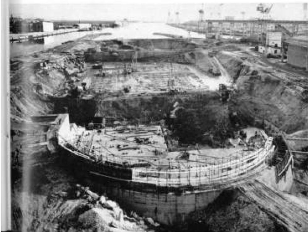
Lo stato di avanzamento dei lavori del bacino gigante del Cantiere di Monfalcone
