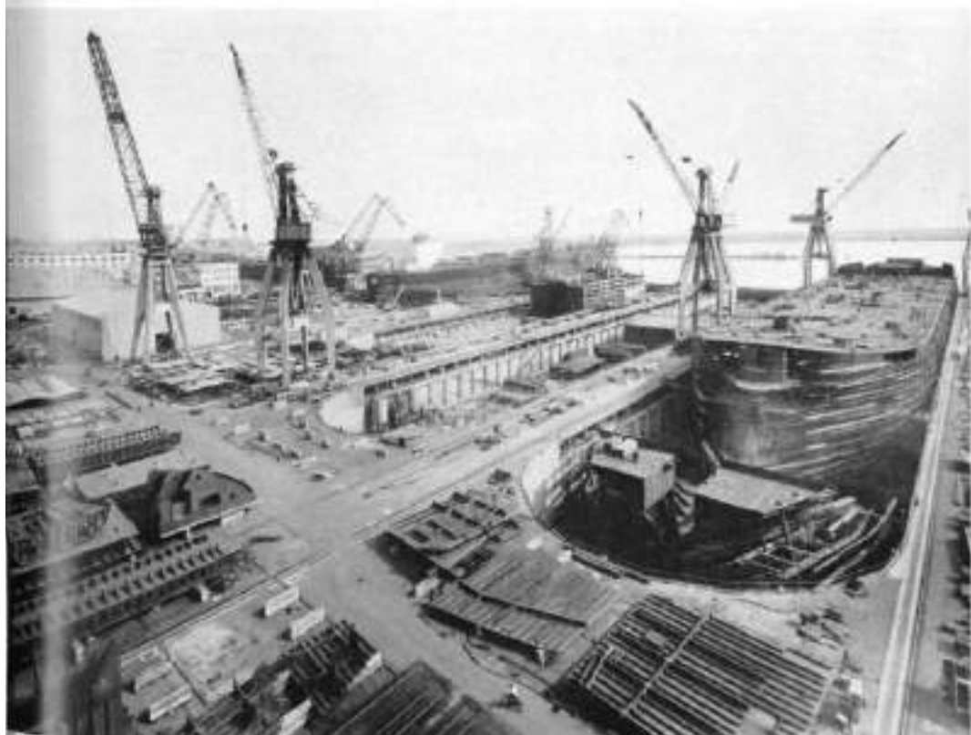
Vista da Nord dei bacini del Cantiere di Genova-Sestri
