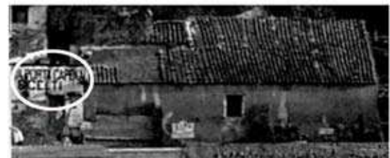
Fig. 14 - Testimonianze epigrafiche dell'esistenza dell'osteria nella torre Lepori. In alto: iscrizioni su intonaco bianco nell'angolo nord - est della torre (ICCD E 2917); in basso: l'insegna "Osteria di Porta Capena / Vini scelti" posizionata sul lato della torre rivolto verso il Circo Massimo (BSR Archive, Mackey collection, n. 1243). Nell'immagine le scritte superstiti sono integrate con caratteri a stampa: [OSTERIA], [VER]DURA, [PRE]ZZI [SCON]TATI.
