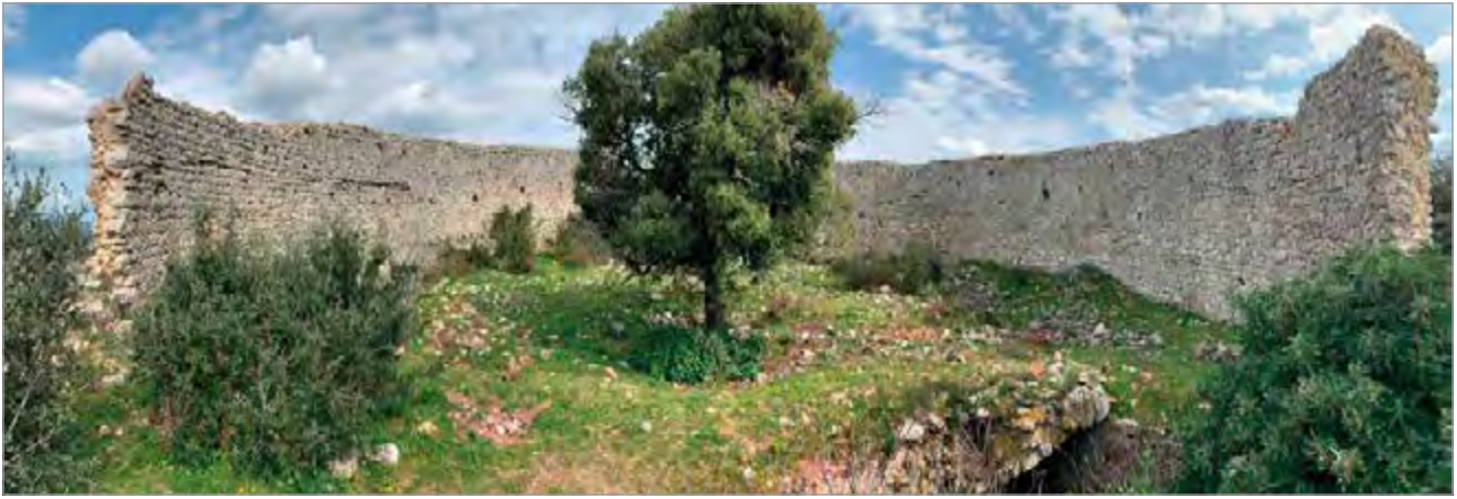
fig. 69 – Interno del Tino di Moscona.
