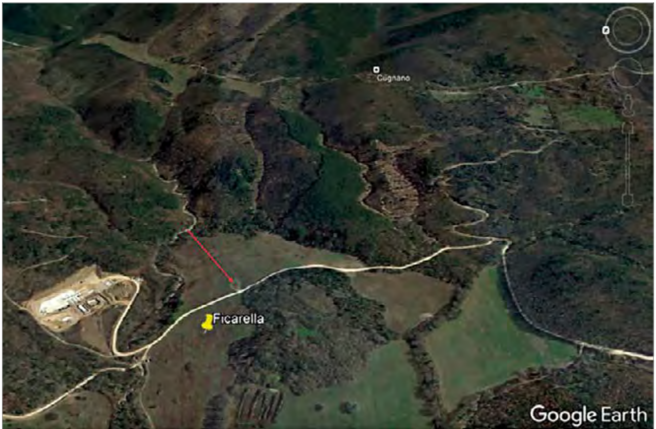
fig. 159 – Ficarella. La freccia rossa indica il movimento di provenienza dell'ipotetica frana.
