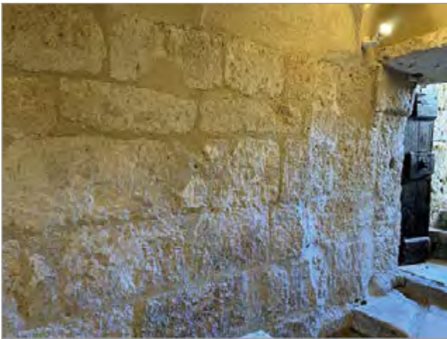
fig. 103 – Particolare della tecnica muraria a grandi conci della cripta sottostante la Sagrestia. Si noti come il muro non abbia cesure in corrispondenza dello stipite della porta di ingresso, testimoniando così la contemporaneità con questo ambiente dell'apertura che conduce alla facciata della Sagrestia.
