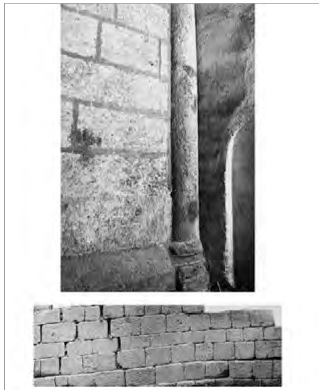
fig. 72 – Esempi di tecniche murarie presenti in area grossetana nel XII secolo. In alto la tecnica muraria adottata nel fianco destro della chiesa di S. Pietro a Grosseto (da GABRIELLI 2007, p. 261); in basso la tecnica della torre del castello aldobrandesco di Sassoforte, Grosseto (da FICHERA 2009).
