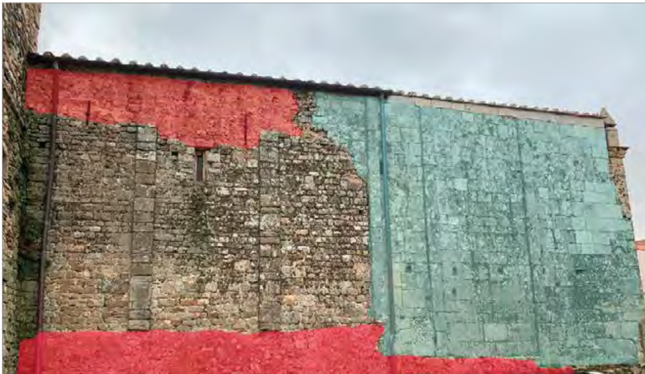
fig. 192 – Isola d’Elba, chiesa di S. Pietro. Fianco sinistro della chiesa con segnati i contorni delle macro fasi: in rosso gli interventi di età moderna e contemporanea; in azzurro la ricostruzione di XII secolo.
