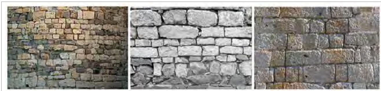
fig. 111 – Tavola di confronto tra le tecniche murarie dell’abside più antico di Sant’Antimo (prima a sinistra) quelle della chiesa di Montieri (al centro) e del San Salvatore al Monte Amiata (a destra).
