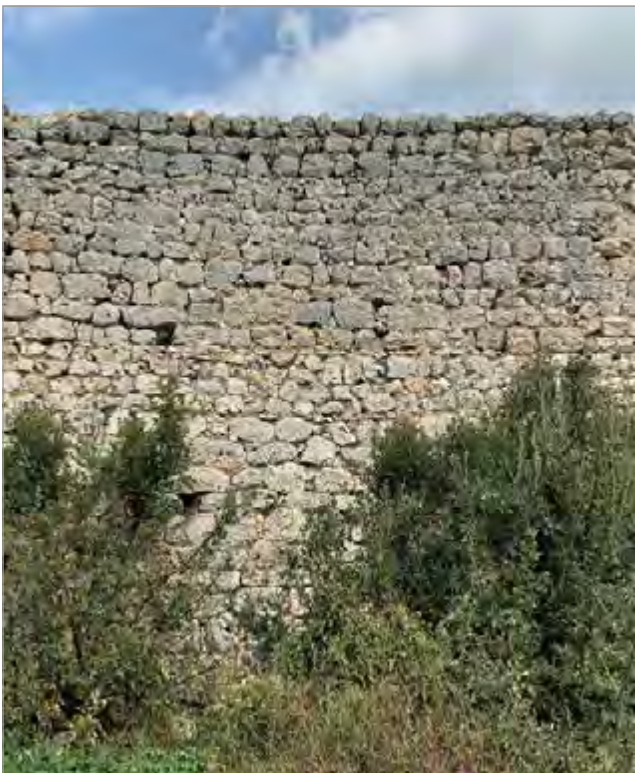
fig. 70 – Particolare della porzione interna di nord-ovest del Tino di Moscona dove è visibile la coesistenza di apparecchiature murarie contraddistinte da pietre di minori e maggiori dimensioni poste in opera più o meno regolarmente.
