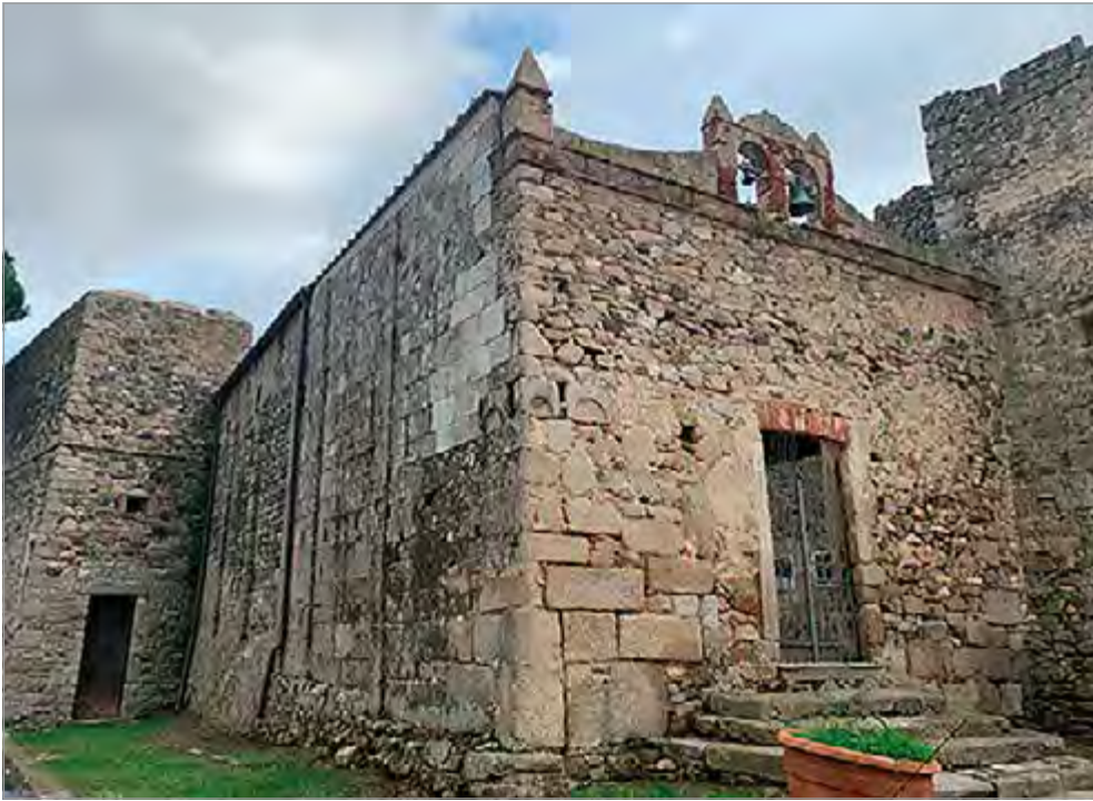
fig. 190 – Isola d’Elba. Facciata e fianco della chiesa di S. Pietro in Campo.
