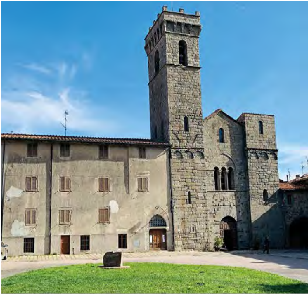
fig. 83 – Il monastero di San Salvatore (Abbadia San Salvatore).
