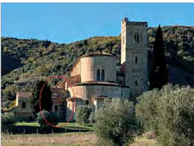
fig. 104 – La parte absidale della chiesa abbaziale. Con il cerchio è indicata l'abside più antica in fase con l'attuale ambiente della Sagrestia.
