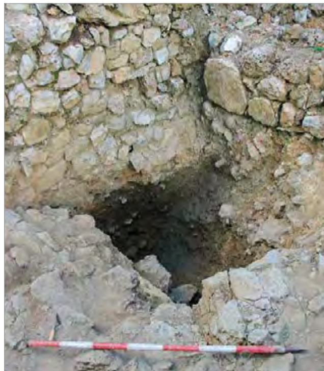
fig. 155 – Cugnano. L'escavazione 2 dopo l'asportazione di parte del suo riempimento (archivio fotografico UNISI).
