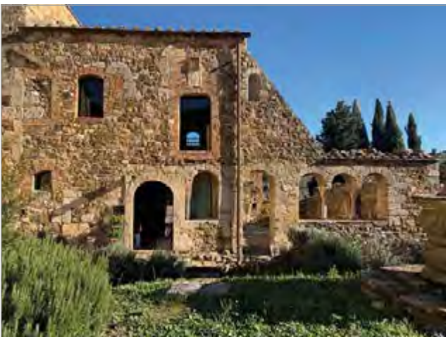
fig. 110 – La facciata dell'originaria Sala Capitolare.
