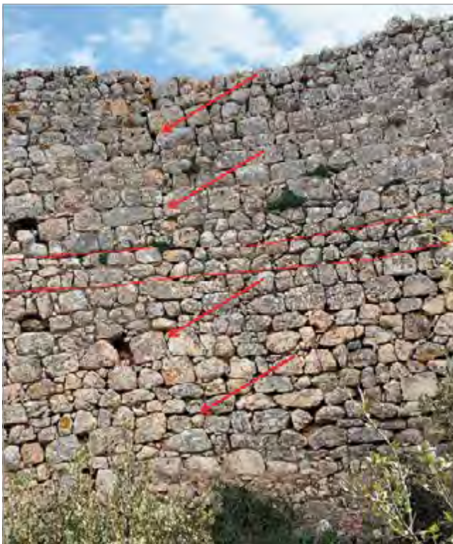
fig. 71 – Particolare della muratura interna del Tino di Moscona dove si nota la presenza di apparecchiature differenziate. La parte inferiore e superiore sono divise da due filari a formare una sorta di bancata in muratura. Nelle porzioni inferiori e superiori è comunque presente una cesura di accrescimento verticale in corrispondenza della quale si è, in seguito, creata una fessurazione.
