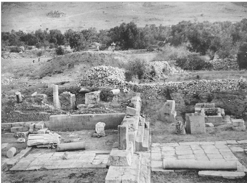
Fig. 6. L'edificio in fase di scavo nel 1899 (da SAVIGNONI et alii 1907).
