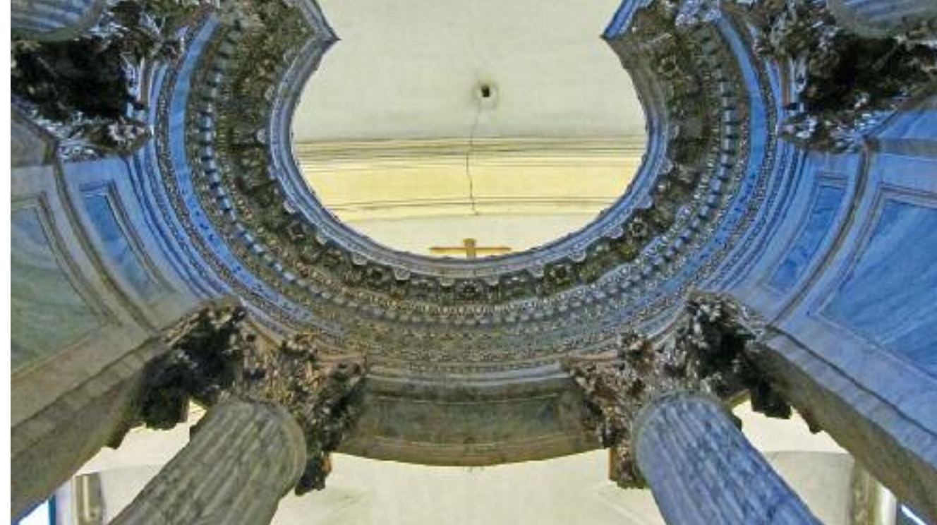
La voûte de la croisée Depuis le maître-autel Avant travaux, 2010.
