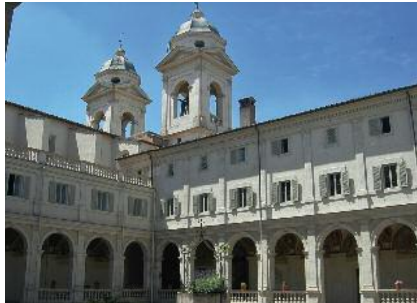
Cloître Galeries sud et est Après travaux, 2015
