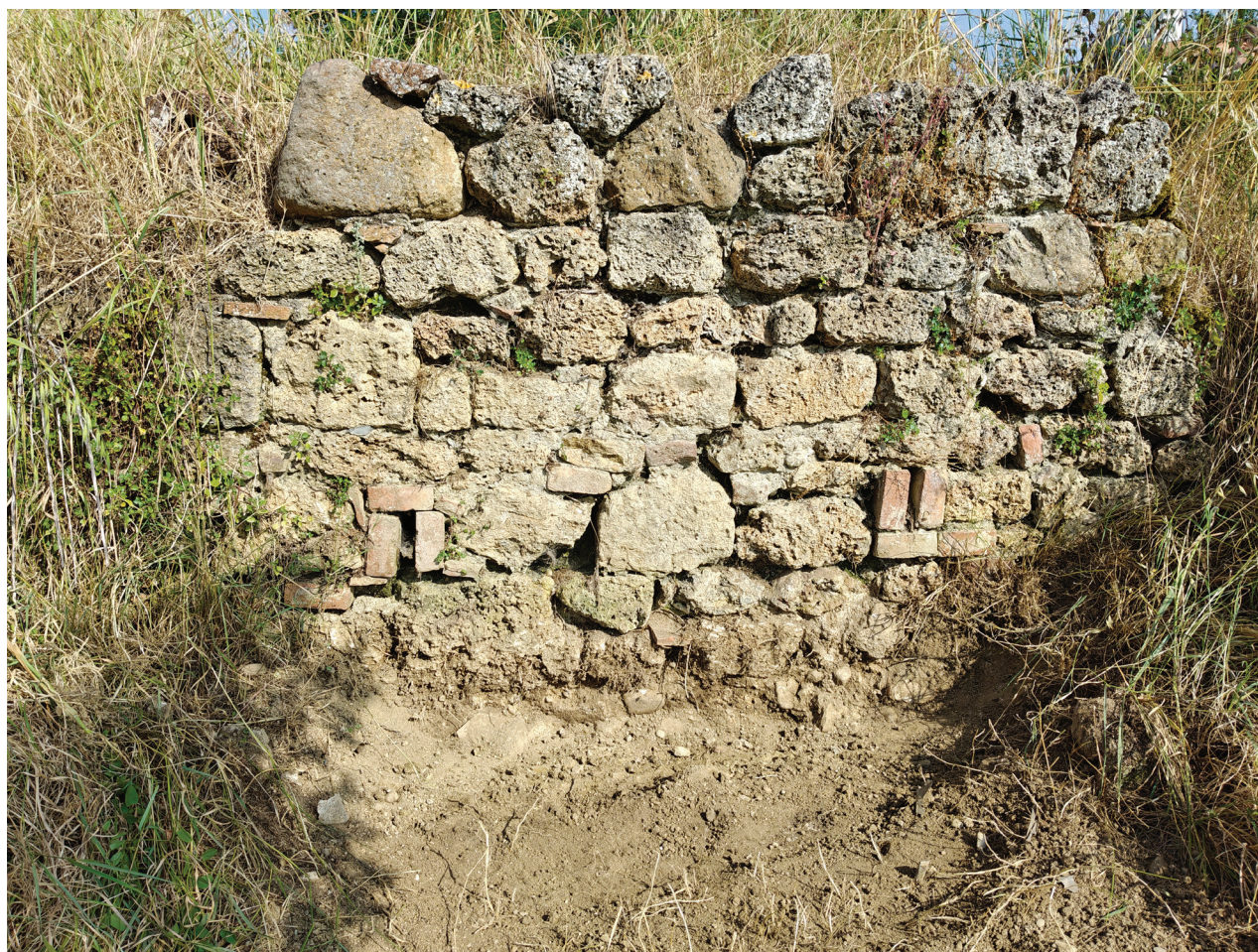
Fig. 4 – Grancia di Ticchiano. Dettaglio della muratura perimetrale messa in luce dopo la pulizia della vegetazione. La tecnica costruttiva e la presenza di buche pontae suggeriscono una funzione difensiva della struttura.
