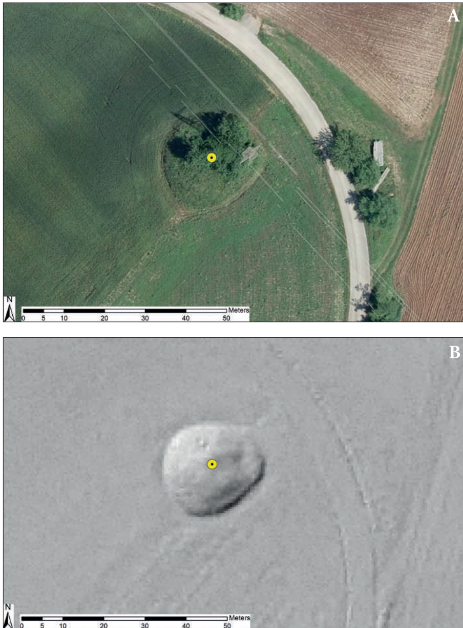
Fig. 11 - Tumulo di Lonzan (Premariacco, UD). (A) La fotografia aerea (2020) mostra il traliccio dell'alta tensione che danneggia il tumulo. (B) I dati LIDAR evidenziano la forma e rendono quantificabile l'estensione del danno.
