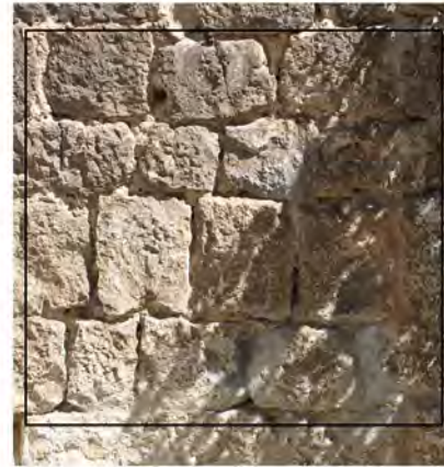
Tecnica 6. Palazzo di Checco il bello. Campione in scala 1X 1 m.
