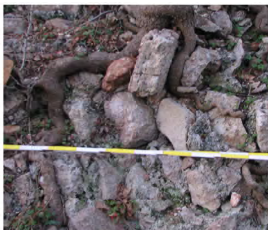
Tecnica 3. Edificio 18. Riempimento
