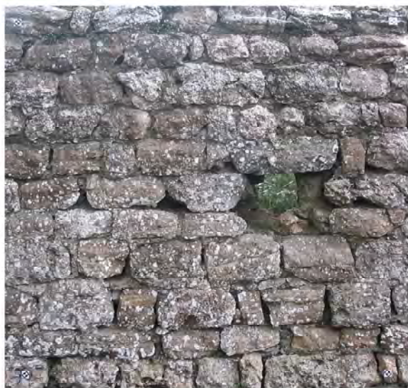
Tecnica 1. Recinto calustrale. Campione 1,5 X 1,5 m.
