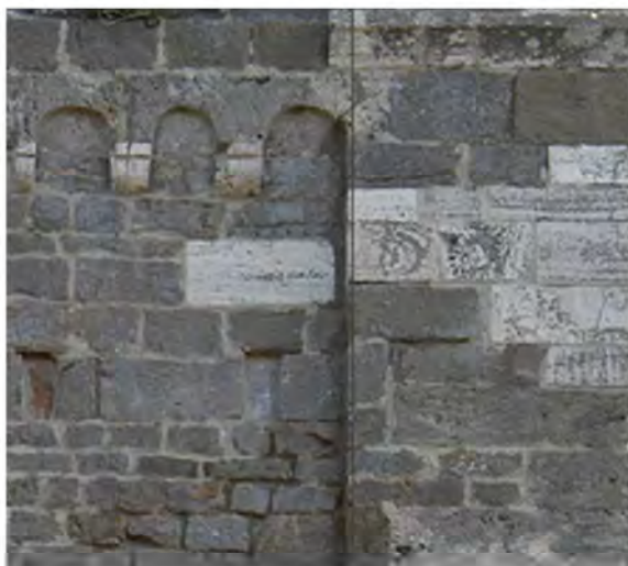
Tecnica 6. Torre campanaria. Campione non in scala.
