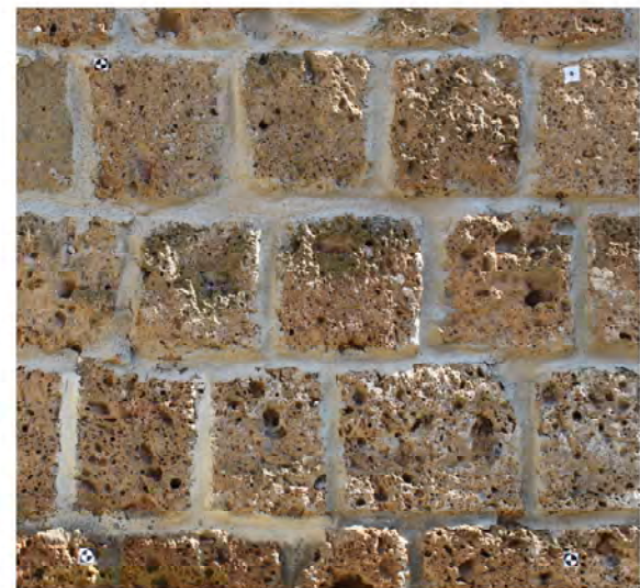
Tecnica 12, Rifacimento della chiesa di Santa Maria. Campione in scale 1X 1 m.
