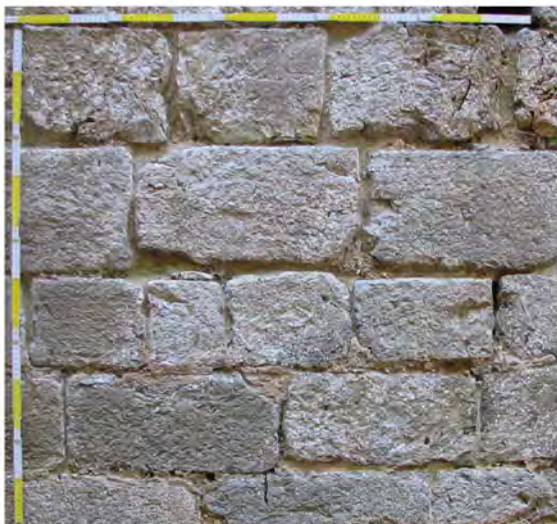
Tecnica 8. Edificio nord-ovest addossato al campanile. Campione in scala 1 X 1 m.
