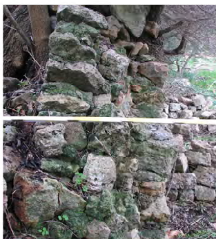
Tecnica 6. lacerto murario. Riempimento
