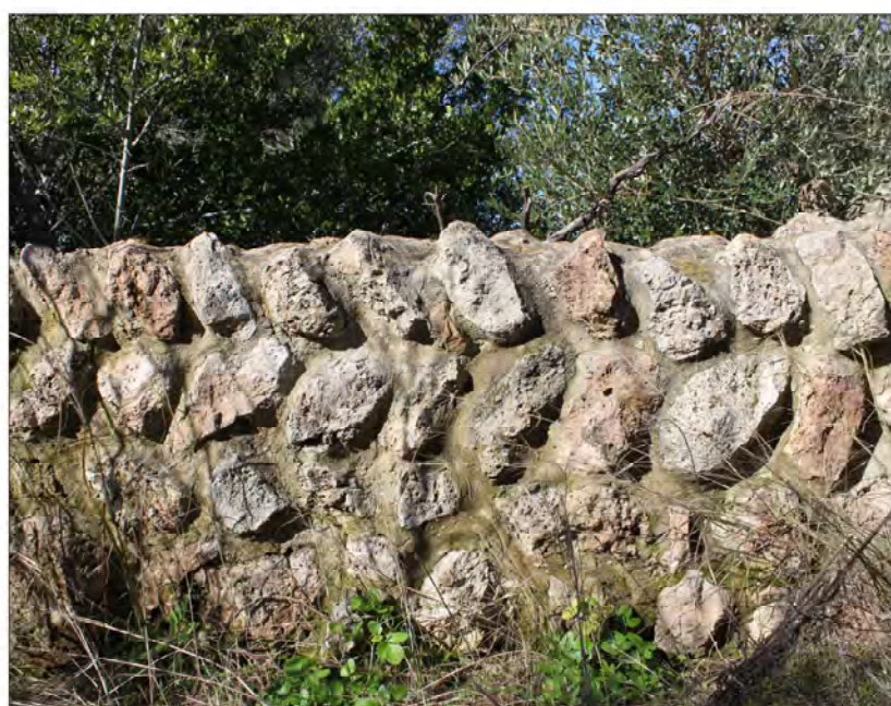
Fig. 30 Particolare della decorazione a spina pesce individuata nella cinta muraria
