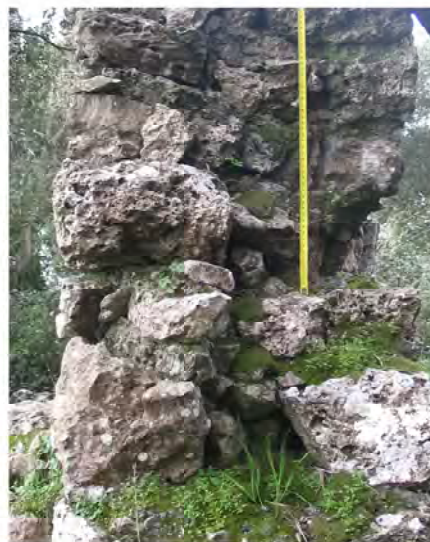
Tecnica 1. Recinto claustrale. Riempimento
