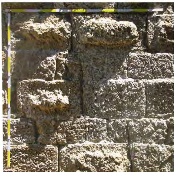
Tecnica 7. Torre rettangolare. Campione in scala 1 X 1 m
