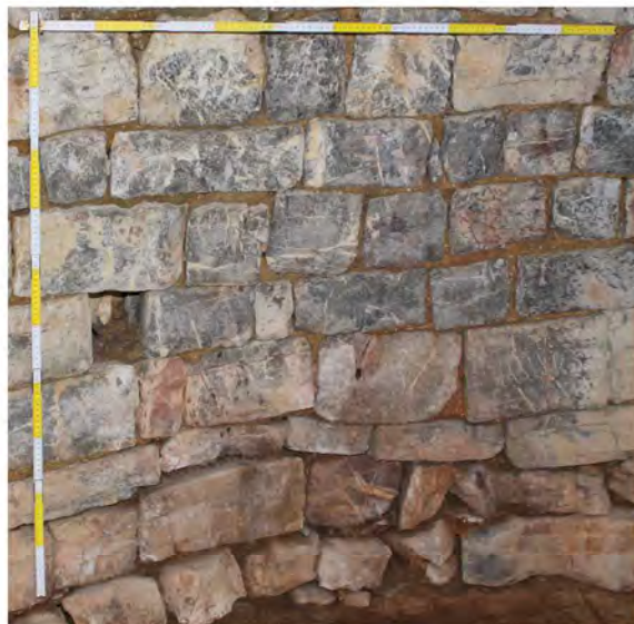
Tecnica 1. Torre circolare. Campione in scala 1 X 1 m.
