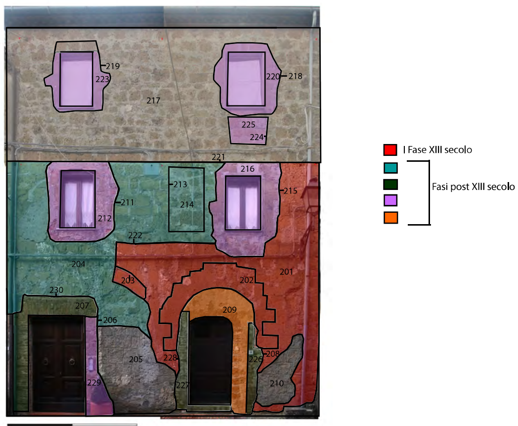
Fig. 66 Edificio B. Prospetto Generale 2 . In alto fotoraddrizzamento; in basso lettura stratigrafica e individuazione delle principali fasi costruttive.
