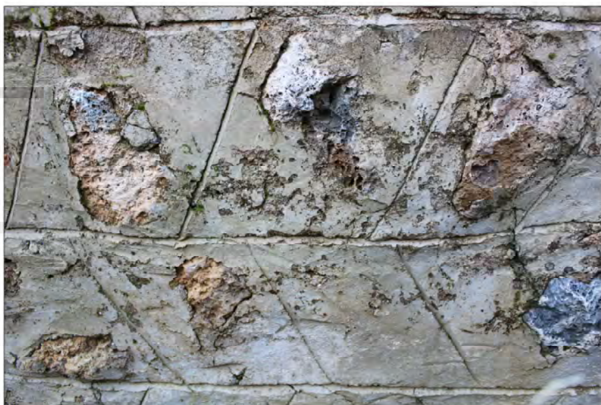
Fig. 28 Particolare della malta rifluente e stilata a formare dei rombi che richiama il motivo a spina di pesce, presente nella porzione inferiore dell'abside
