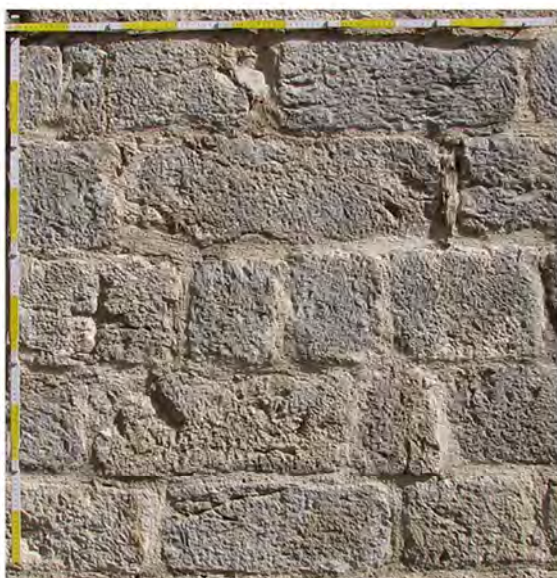
Tecnica 5. Base della torre campanaria. Campione in scala X 1 m
