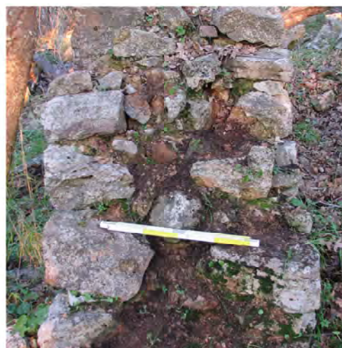
Tecnica 2 variante A. Edificio 17=K. Riempimento
