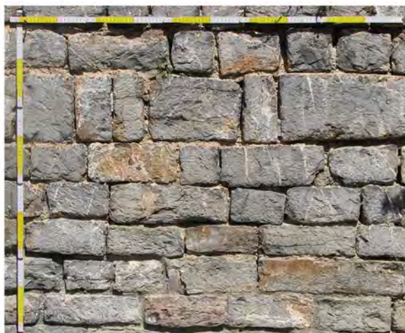
Tecnica 3. Chiesa. Campione in scala 1 X 1 m.
