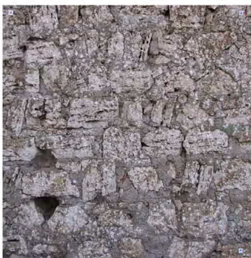
Tecnica 7. Edificio 3=J. Campione 1,5 X 1,5 m.
