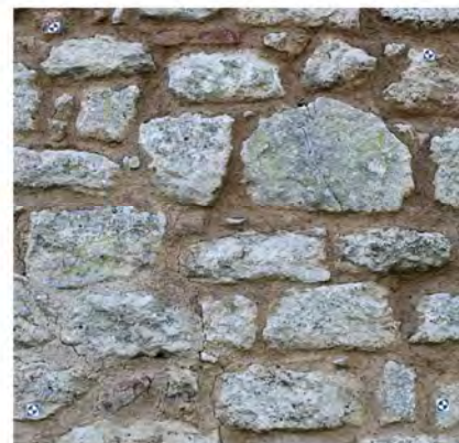
Tecnica 8 Rifacimento della cinta senese. Campione in scala 1X 1 m.
