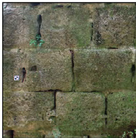
Tecnica 3 Primo nucleo della Rocca Aldobrandesca. Campione 1X1 m.
