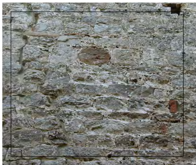
Tecnica 11. Rialzamento dei muri della chiesa e del recinto. Campione non in scala
