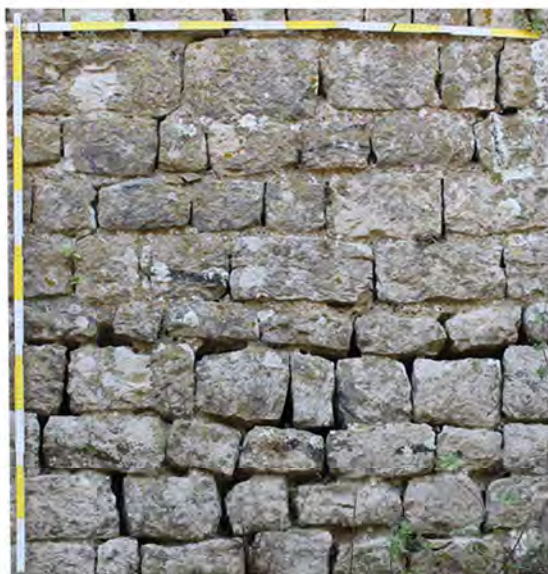
Tecnica 4. Recinto e ambienti funzionali al monastero. Campione in scala 1 X 1 m
