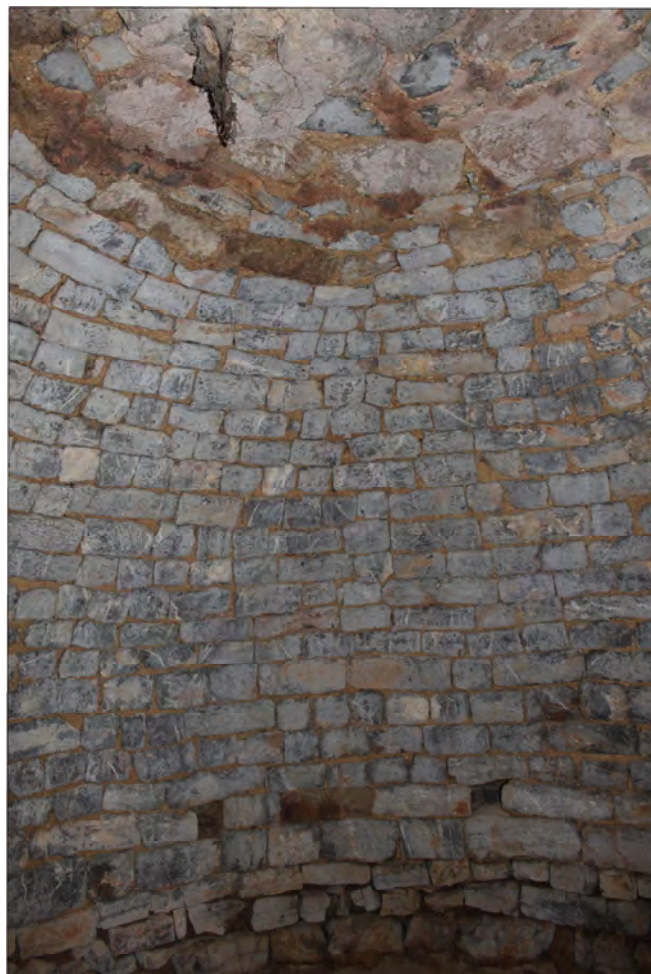
Fig. 44 Planimetria interpretata del monastero di Santa Maria Alborense: Torre circolare; a destra particolare della volta a botte in pietra a copertura dell'ambiente interno della torre.
