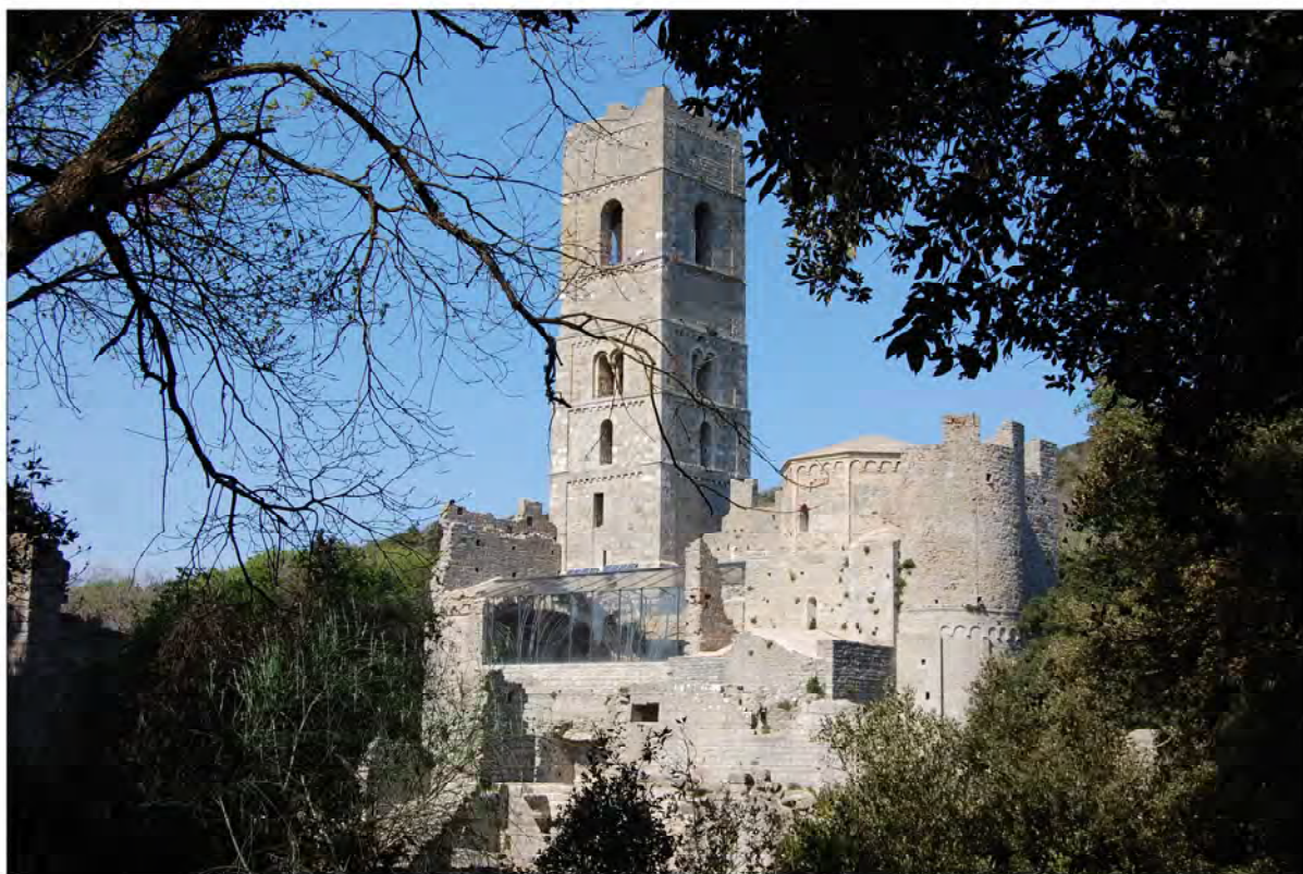
Fig. 42 Vista generale da est del monastero benedettino di Santa Maria Alborense.
