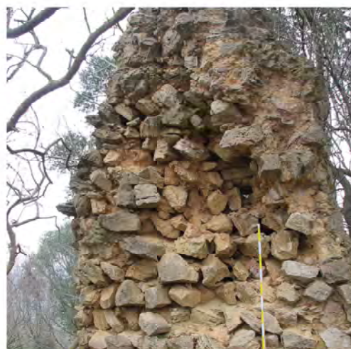
Tecnica 4. Accesso nord. Riempimento
