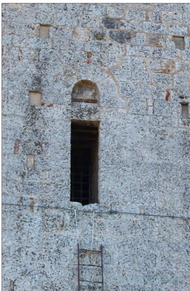
Fig. 25 Particolare della porta d'accesso alla torre posta a qualche metro d'altezza rispetto al piano di calpestio.
